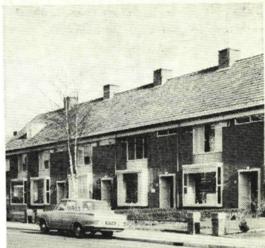
Woningen waar de gang en de keuken aan de woonkamer van de buurman grenst
