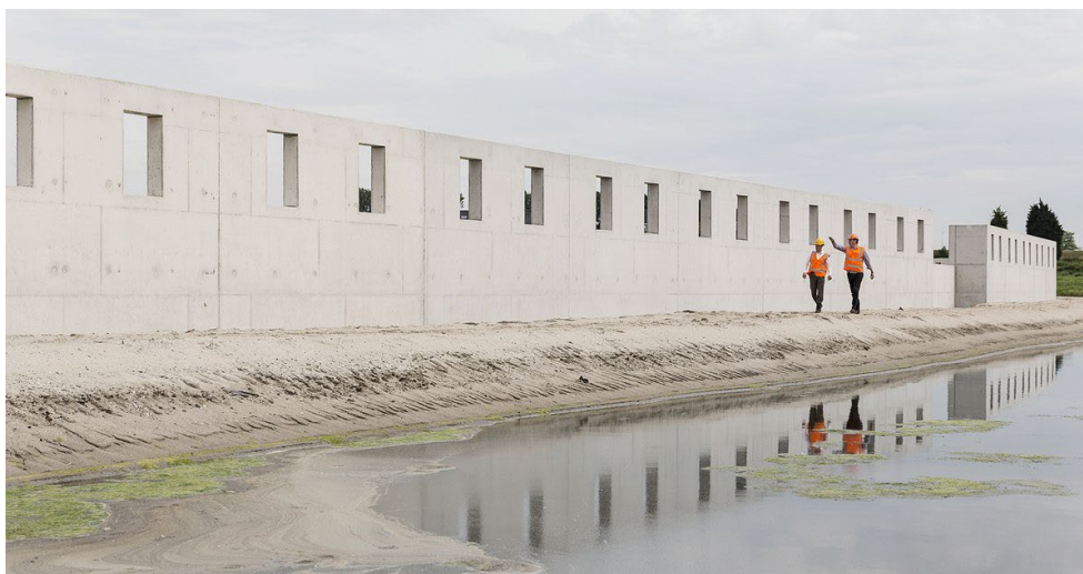
Figuur 8: de golfbreker bij installatie (Heijmans, 2016)
