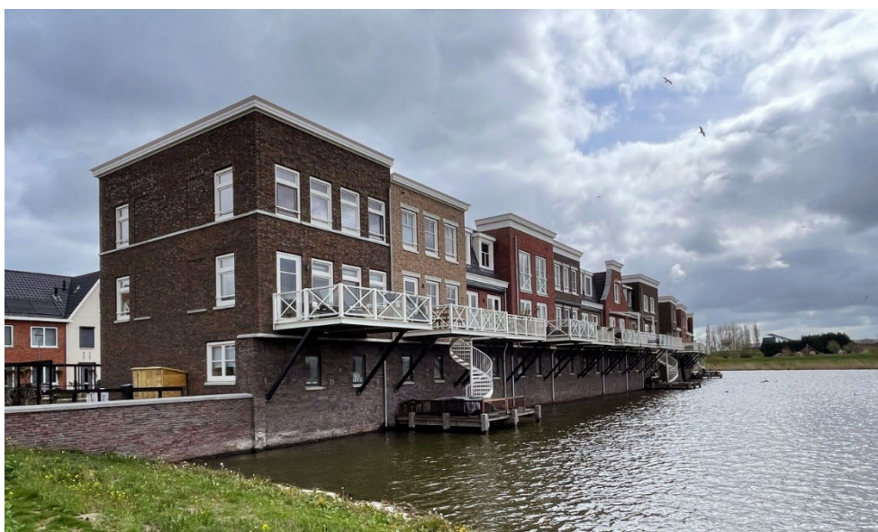
Figuur 9: Golfbreker met woning gerealiseerd erop (Bureau070, n.d.)
