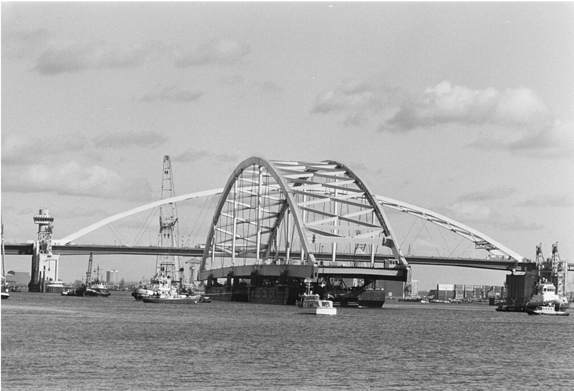
Invaren Tweede van Brienenoordbrug 1990 Oorzaken vermoeiing stalen brugdekken
