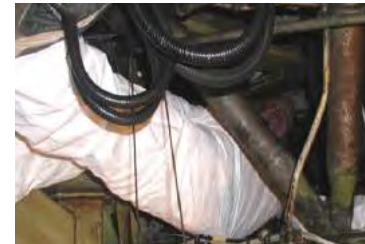
Inspectie in de praktijk
