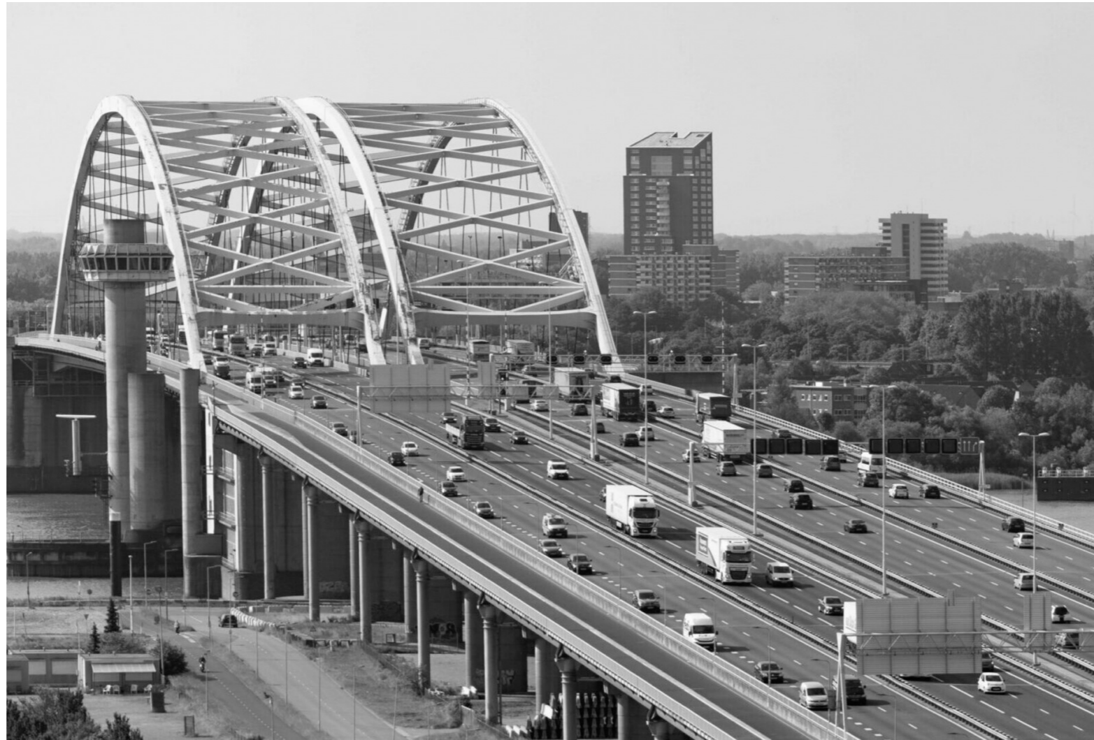
Van Brienenoord Bridge (Meulstee, 2026)
