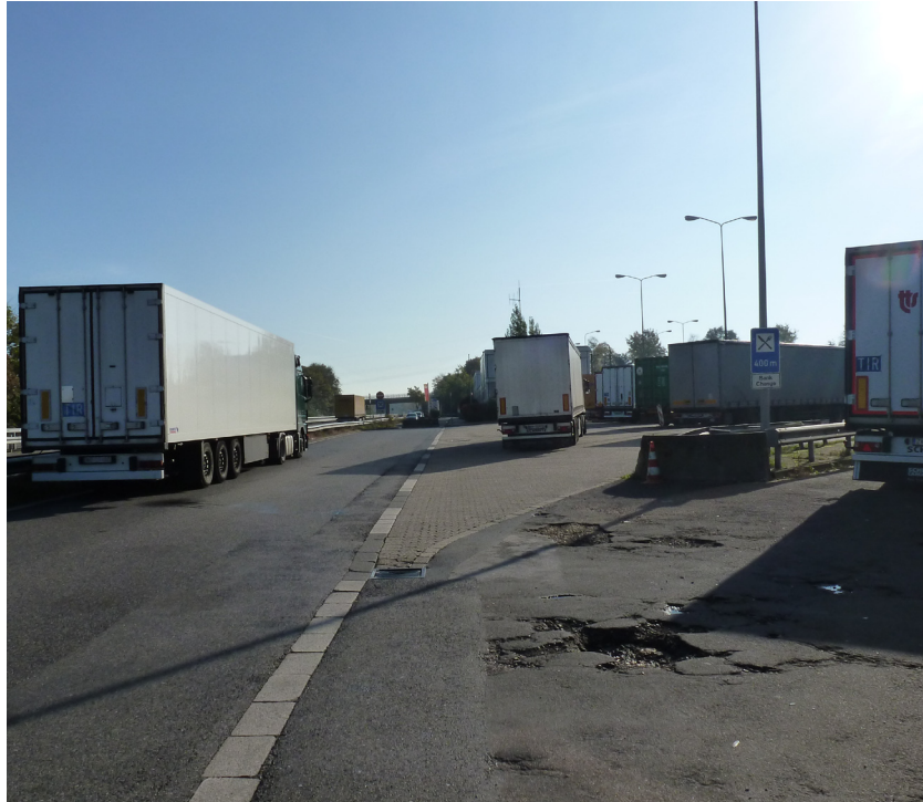
Vervallen parkeerplaatsen Duits grensplacement
