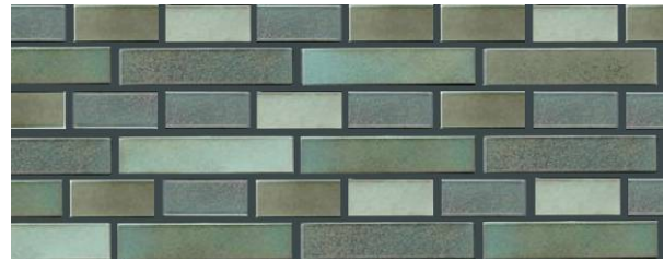
Figuur 3.4: Metselwerk van donkergroene glazuurbakstenen, toegepast in klassiek kruisverband.
