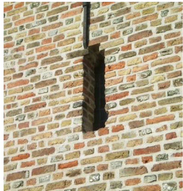
Figuur 4.4: Sleufvormig schietgat in een authentieke kasteelmuur. (Bron: http://www.bovenlichten.net/ )
