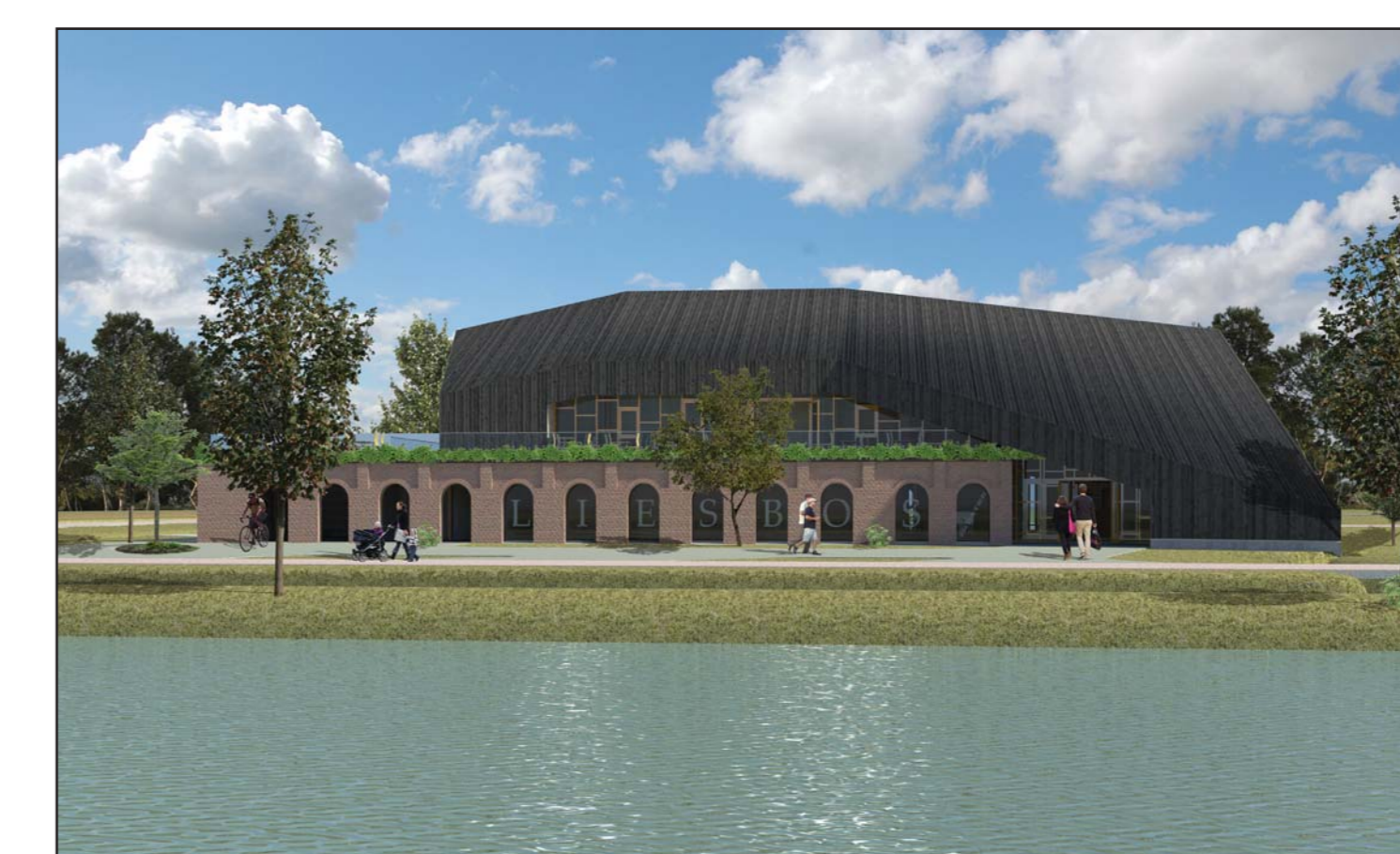
Aanzicht vanaf overkant Merwedekanaal
