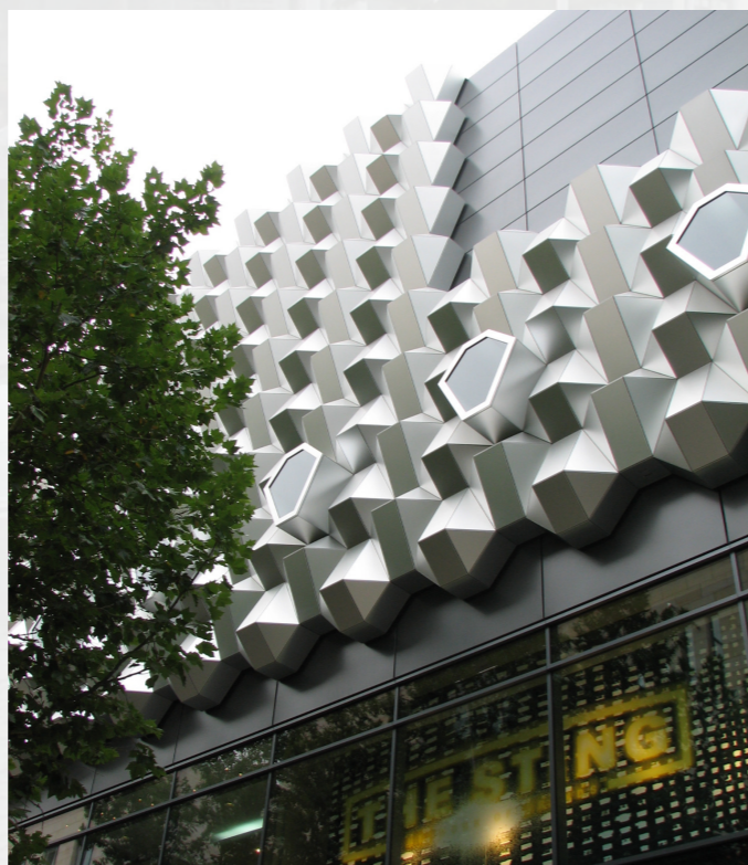
Fig. 34 Het Centraal Warenhuis na de renovatie, medio 2009.
