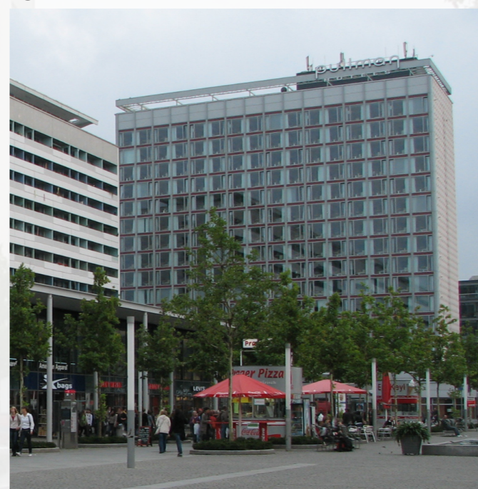
Fig. 28 Zicht op Hotel Newa, na de renovatie
