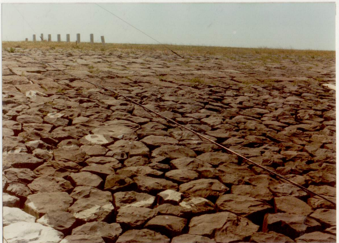
Foto 2 Golfploopmeter aangebracht op talud (Afsluitdijk).
