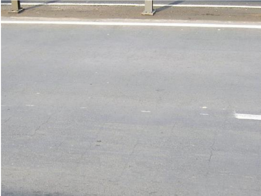
Figuur 8 Krimpscheuren door autogene krimp in HSB overlaging
