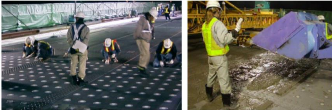
Figuur 99 Het plaatsen van a) de plaatdeuvels en b) de ECC mortel op de Mihara brug
