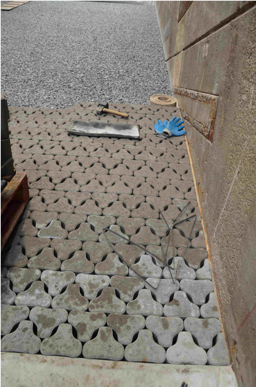
a) Opbouw model: plaatsens van steenzetting (3)
