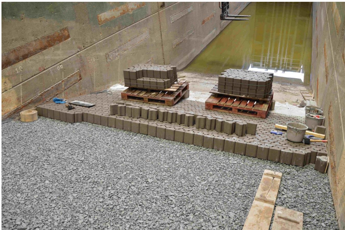
b) Opbouw model: plaatsing van steenzetting (2)
