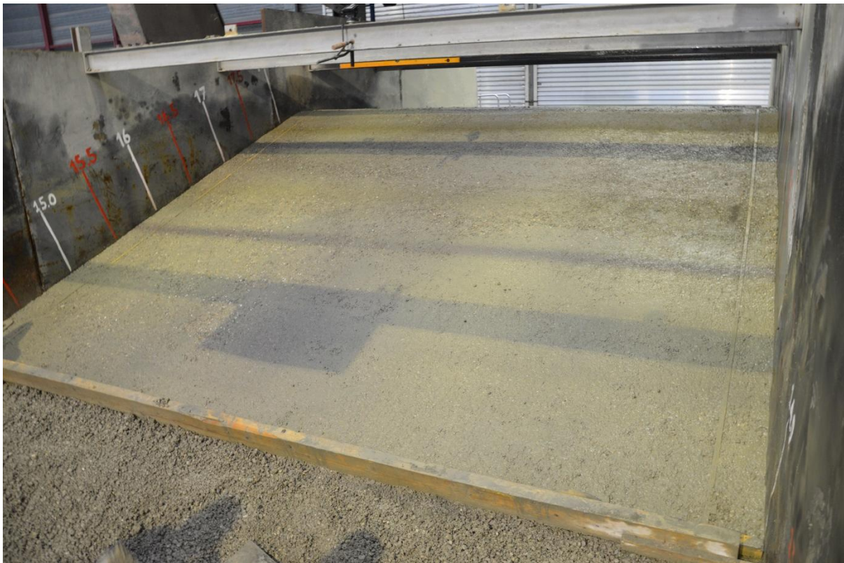
b) Opbouw model: afwerken van talud (2)
