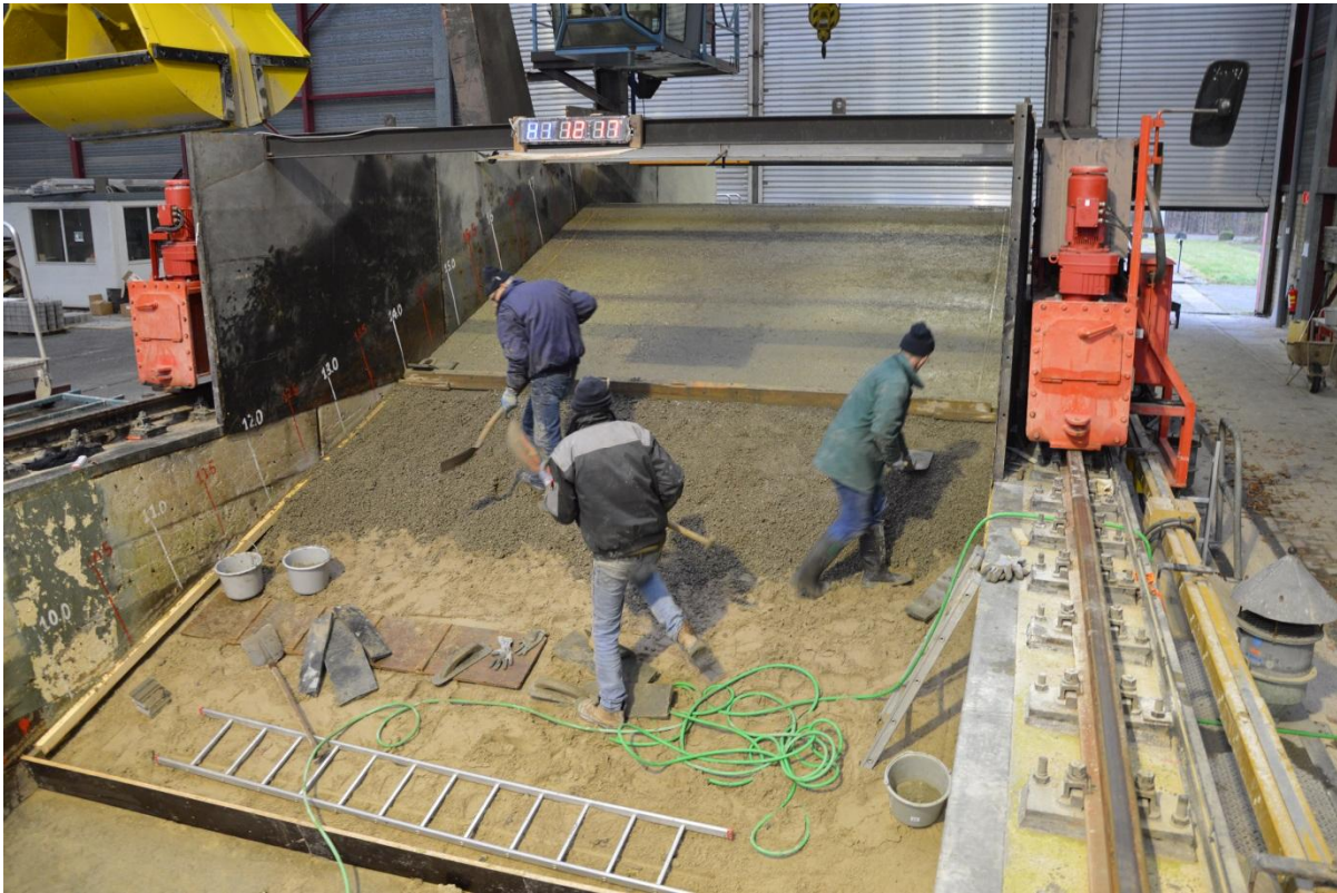
a) Opbouw model: afwerken van talud (1)
