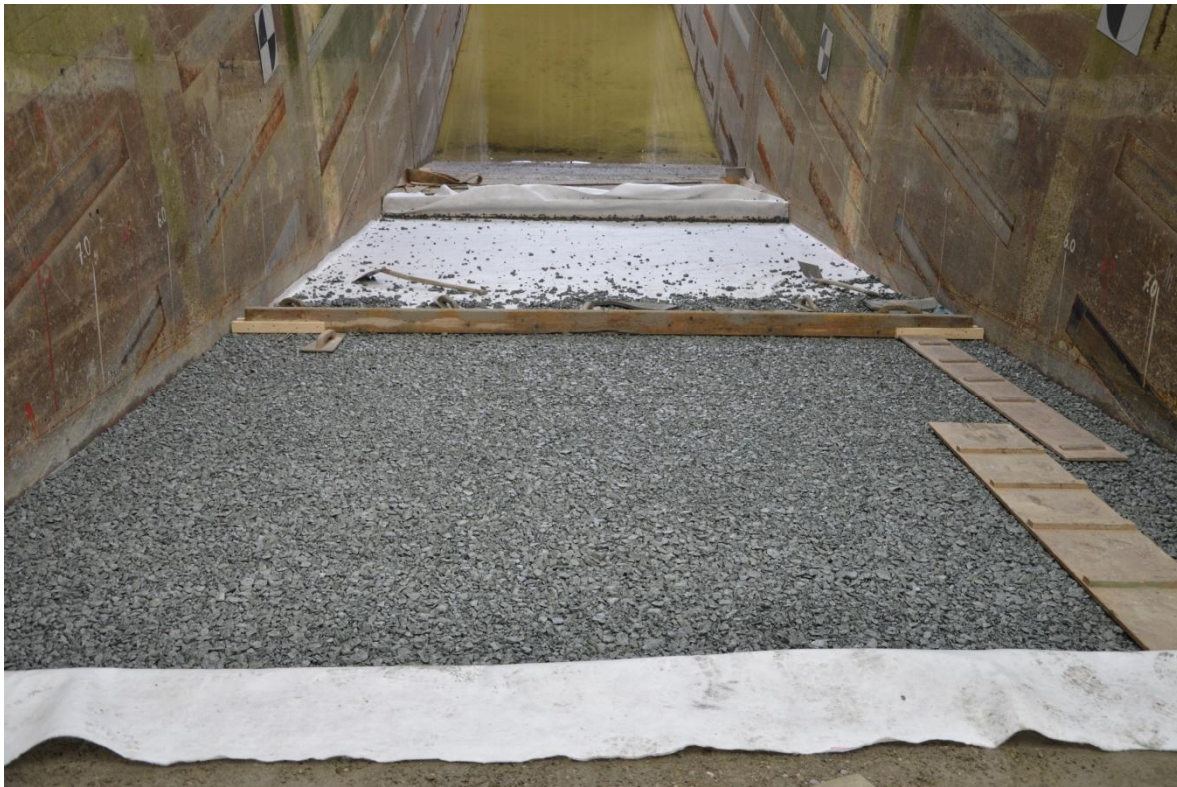
b) Opbouw model: plaatsen van filterlaag
