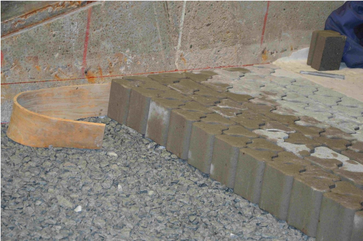
a) Opbouw model: plaatsing van steenzetting (1)
