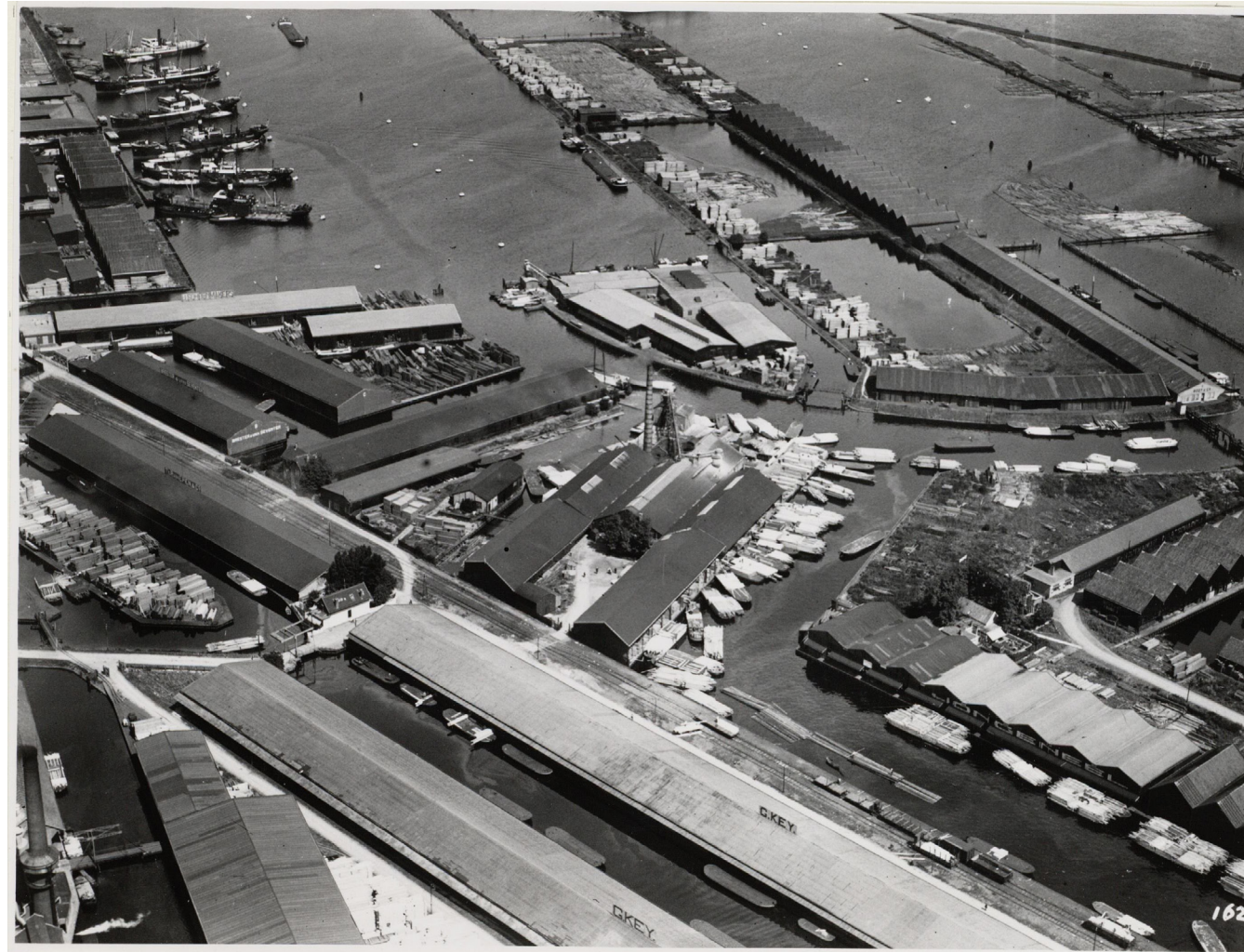
Figure: Stadsarchief Amsterdam. (1924). Luchtfoto van de Rigakade gezien in noordelijke richting naar de Nieuwe Houthaven [Photograph]. Retrieved from (17-04-2019), https://beeldbank.amsterdam.nl/beeldbank/weergave/record/layout/indeling/gallery/sortering/sk_sort_geografische_naam_ASC?f_sk_geografische_naam=Rigakade&id=A04139000185
