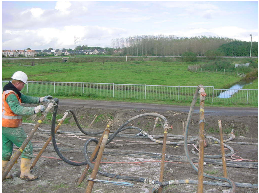
Figuur 12 Het vullen van de expanders. De grout wordt aangevoerd door de aan de injectiebuisen aangesloten slangen.
