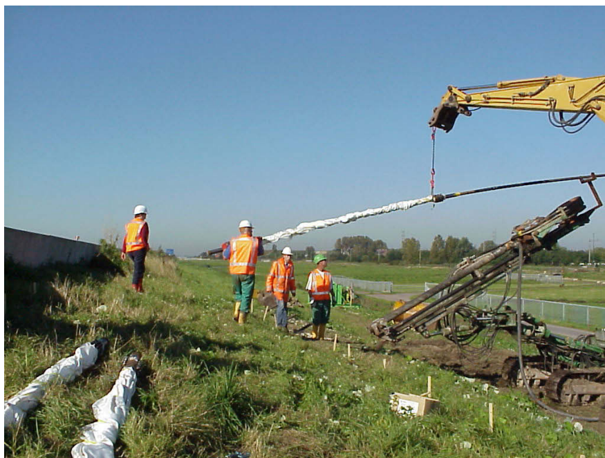
Figuur 11 Het inbrengen van een expander in een boorgat onder het weglichaam. Rechts is de groutankermachine die de boorgaten heeft gemaakt.
