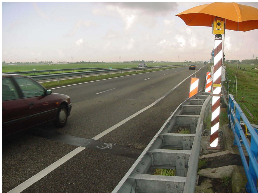
Figuur 7 Het te onderhogen gedeelte van de noordelijke rijbaan van de N11. De kromming van de rechterkantstreep duidt op een kuil in het asfalt.
