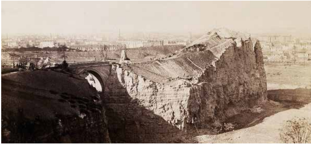
FIGURE 5.2 Travaux d'aménagement du parc des Buttes Chaumont, c. 1860. (Photo: Charles Marville 1813-1879, Bibliothèque nationale de France).
