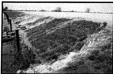
..... Figuur 2.5 ..... Het faalmechanisme 'overloop/overslag' (DWW)
