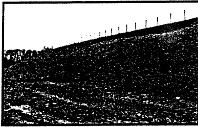
..... Figuur II.O.2.6 ..... Een waterkering bezwijkt zonder te falen als er grote vervormingen zijn opgetreden zodat de samenhang van de constructie verloren gaat zonder dat de functie waterkeren verloren gaat (DWW)
