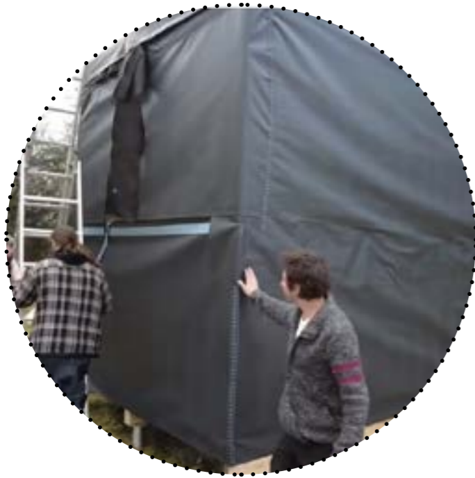
01.AIRTIGHTNESS MEMBRANE + TAPE
