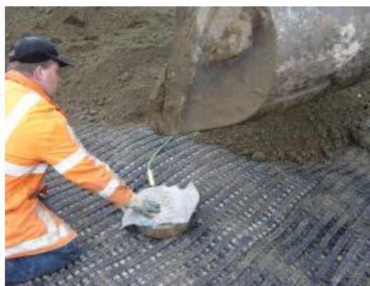
Figuur 3.2 Links: Total Pressure Cell is ingebouwd in constructie met doorsnede 29,4 cm, rechts: installatie van Total Pressure Cell bovenop het geotextiel
