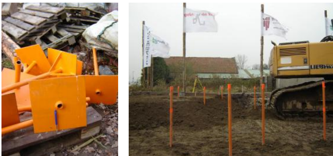
Figuur 3.3 Er werd gewerkt met speciale kleine zakbaken
