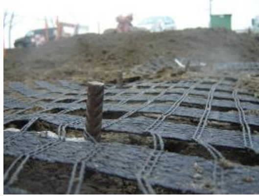
Figuur 4.8 Het geogrid werd langs de randen omgeslagen om de eerste Hegemannlaag.
