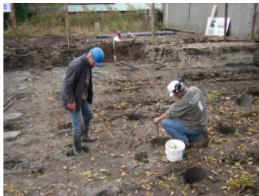
Figuur 4.6 Links: stalen pinnen die in de houten palen worden geslagen, rechts: aanbrengen stalen pinnen.
