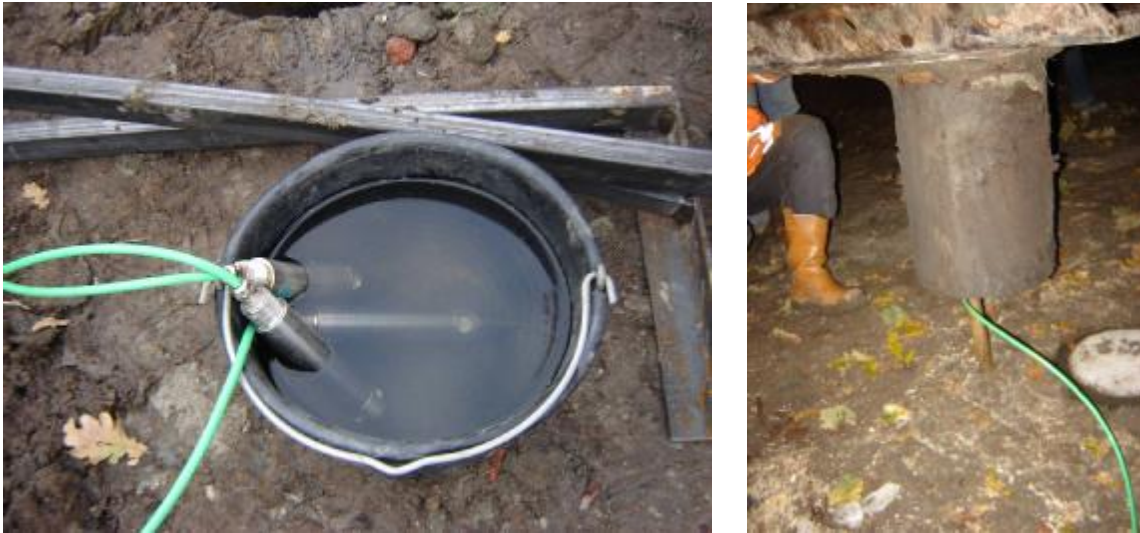
Figuur 3.4 Links: waterspanningsopnemers, rechts: aanbrengen waterspanningsopnemers met behulp van een kraan
