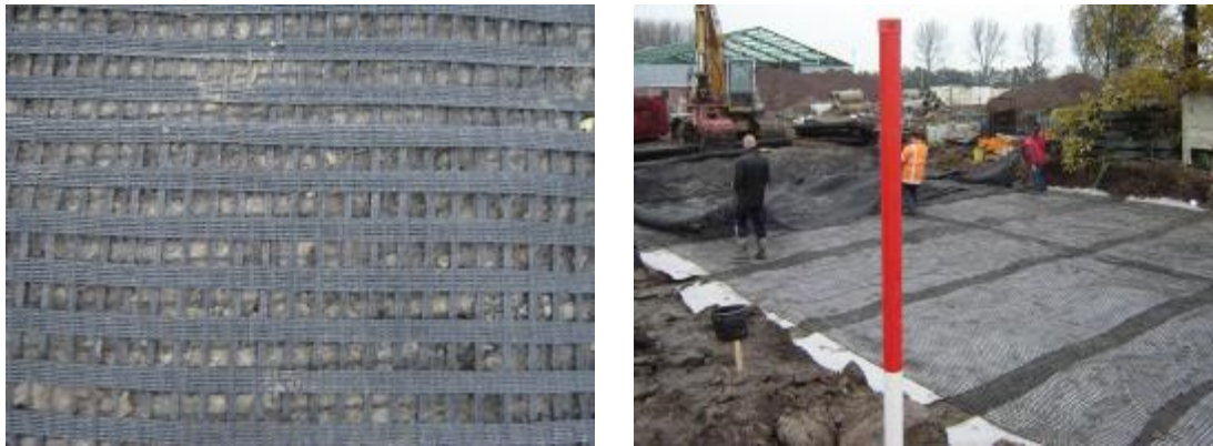
Figuur 4.7 Het geogrid (links ) werd aangebracht op een beschermend doek (rechts).
