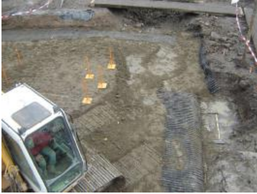
Figuur 4.8 Het geogrid werd langs de randen omgeslagen om de eerste Hegemannlaag.
