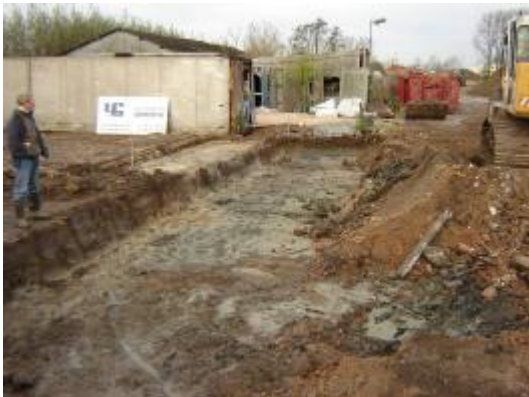
Figuur 4.2 Start graven bouwput
