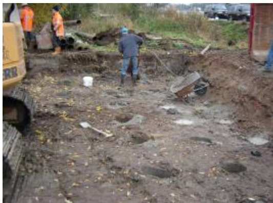
Figuur 4.5 De hoed onder het trilblok heeft gaten boven de palen in de grond geponst.
