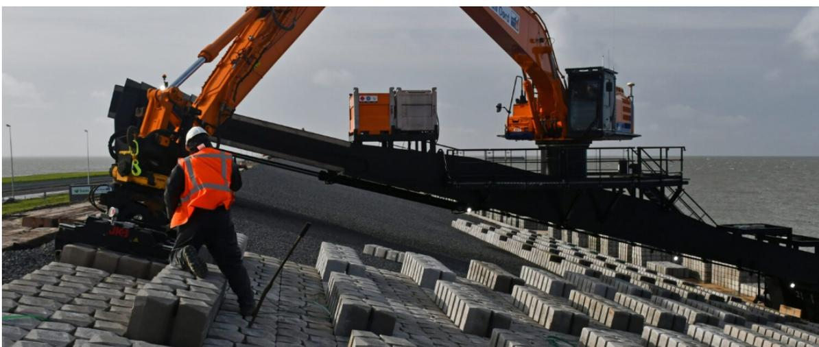
Figure 2.14: Placement of interlocking concrete blocks on the Afsluitdijk (deafsluitdijk.nl, 2021)
