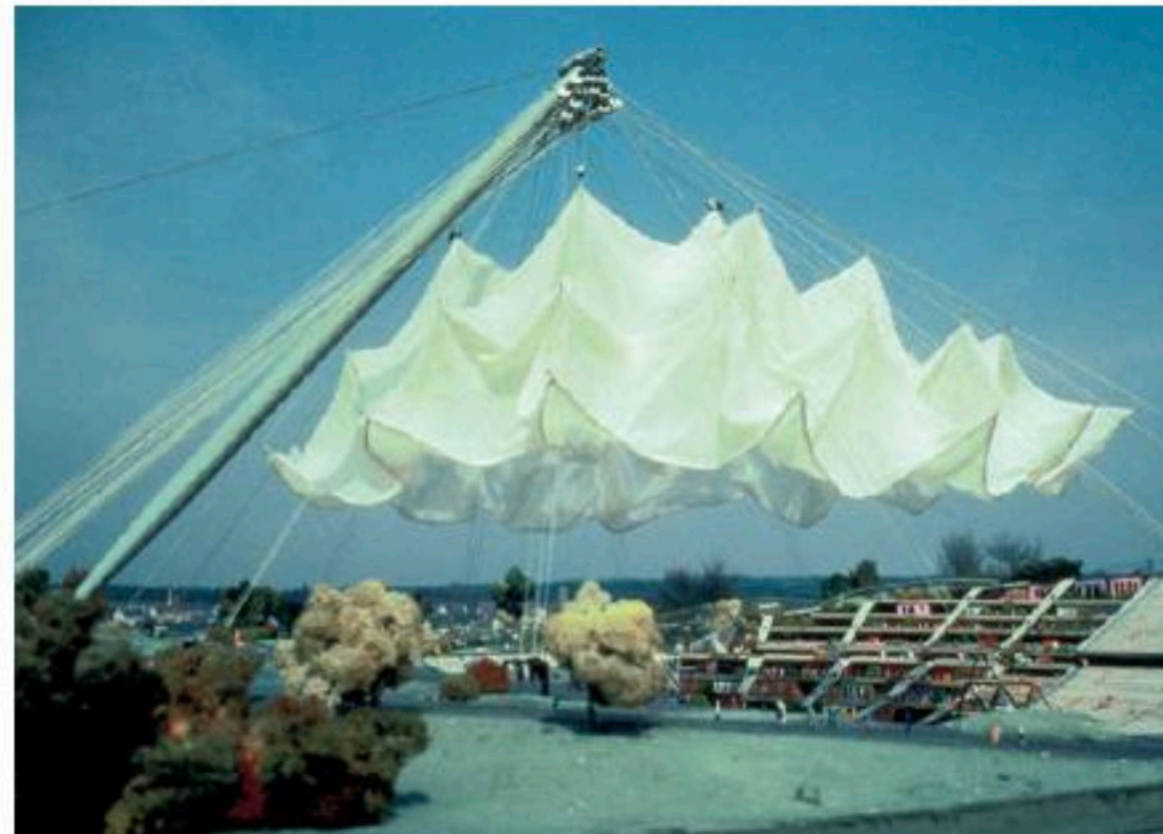
Multimedia-Großraum Multimedia stadium (III.59), Öffnungsvorgang, Modell Opening process, model
