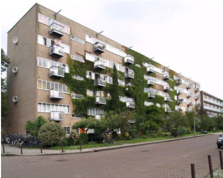
Zomerdijkstraat south façade
