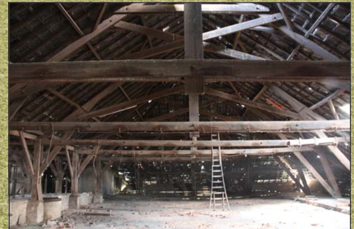
Indirecte inspiratie: zolder steenoven De Plasserwaard, Wageningen
