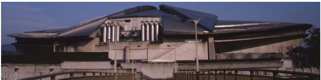
Fumihiko Maki, Metropolitan Gymnasium, 1990, een sporthal voor scholen en verenigingen. De vorm van het dak refereert aan een samuraihelm.
