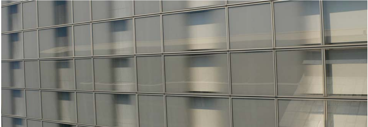
detail van de glazen gevel van Dentsu aan de zijde van het Hama Rikyu Teien
