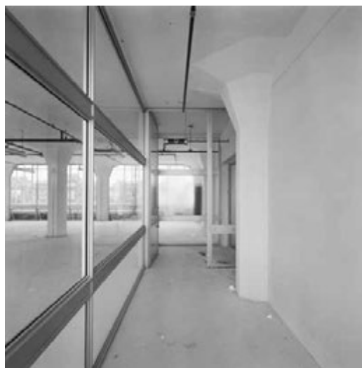
FIGUUR 6.17 Het interieur tijdens de restauratie, in 2004, met de nieuwe binnenwanden.
