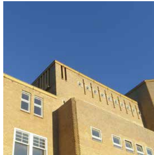
FIGUUR 5.22 Tijdens de restauratie is de dakopbouw op het voormalige badhuis hersteld, 2012
