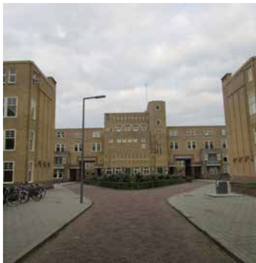
FIGUUR 5.27 Na de restauratie is het oorspronkelijke metselwerk weer zichtbaar, 2014.
