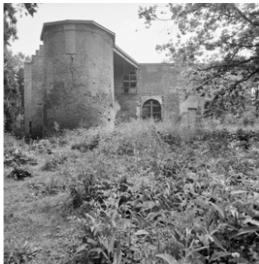
FIGUUR 4.5 Het kasteel in 1989; de 19e-eeuwse voorgevel en één van de torens waren toen al ingestort.
