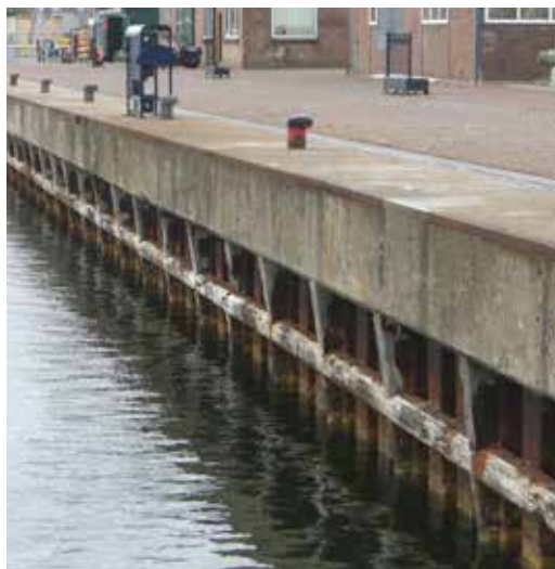
FIGUUR 7.21 Het terrein van de werf werd opnieuw bestraat. Oude onderdelen, zoals hijskranen, kraansporen en bolders, werden behouden om het industriële karakter van het terrein intact te houden. De kade van het natte dok, 2008
