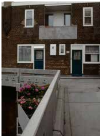
FIGUUR 5.5 Bij de renovatie van het complex werd de betonnen galerij vervangen, werden de plantenbakken uitgevoerd in wit kunststof en werd de indeling van de woningen gewijzigd. De foto uit 1985 toont het eindresultaat met de aluminium kozijnen.
