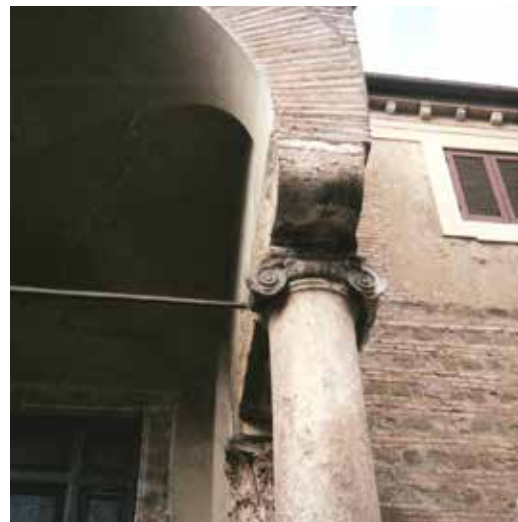
FIGURE 0.3 Een voorbeeld van 'spolia', het hergebruik van bouwonderdelen van antieke monumenten. In de twaalfde eeuw zijn bij de bouw van de Basilica San Clemente in Rome verschillende antieke zuilen hergebruikt; detail van de toegangspoort tot het atrium van het complex.
