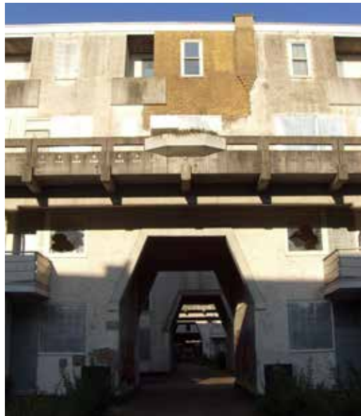
FIGUUR 5.12 Voorafgaand aan de restauratie, die in 2010 startte, was er op verschillende plaatsen geëxperimenteerd met het verwijderen van het schilderwerk van de gevels en het reinigen van het onderliggende metselwerk.
