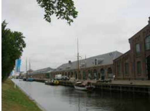
FIGUUR 7.10 De werfgebouwen na hun restauratie en herbestemming tot kantoorruimte. (2008)
