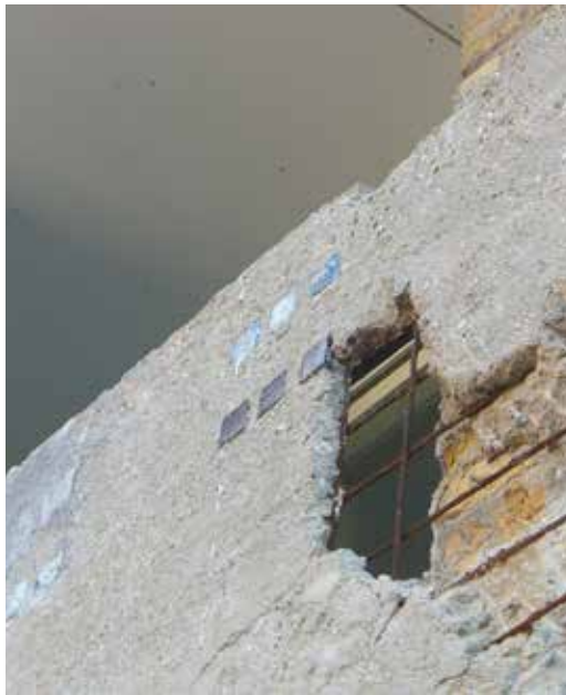
FIGUUR 5.23 In aanloop naar de restauratie bleken er nog oorspronkelijke onderdelen aanwezig, zoals deze betonnen balustrade met ingelegde tegeltjes van één van de balkons, 2012
