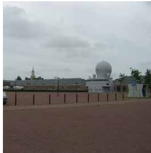
FIGUUR 7.20 Het terrein van de werf werd opnieuw bestraat. Oude onderdelen, zoals hijskranen, kraansporen en bolders, werden behouden om het industriële karakter van het terrein intact te houden. Op de achtergrond zijn de werfgebouwen zichtbaar.
