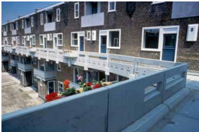
FIGUUR 5.6 Bij de renovatie van het complex werd de betonnen galerij vervangen, werden de plantenbakken uitgevoerd in wit kunststof en werd de indeling van de woningen gewijzigd. De foto uit 1985 toont het eindresultaat; de tuintjes zijn verwijderd en de helft van de wc-raampjes zijn vervangen door verlichtingsarmaturen.
