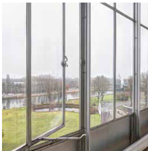
FIGUUR 6.19 De afmetingen, opbouw en detaillering van de nieuwe vliesgevel van het kantoor wijken af van die van de oorspronkelijke. Juist de vliesgevels worden beschouwd als één van de meest waardevolle en karakteristieke onderdelen van de fabriek. Bij de restauratie werden de vliesgevels daarom niet vervangen door hedendaagse exemplaren, maar werden zij gerestaureerd. De nieuw aangebrachte binnengevel en de kantoorwanden zorgen nu dat in de verblijfsruimten thermisch comfortabel is. (Vliesgevel, 2012)
