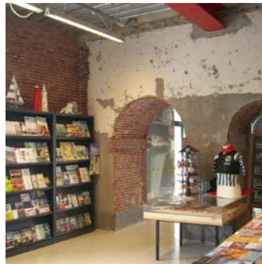
FIGUUR 7.18 Bij de restauratie werd de gelaagde geschiedenis van het pompgebouw zichtbaar gehouden.
