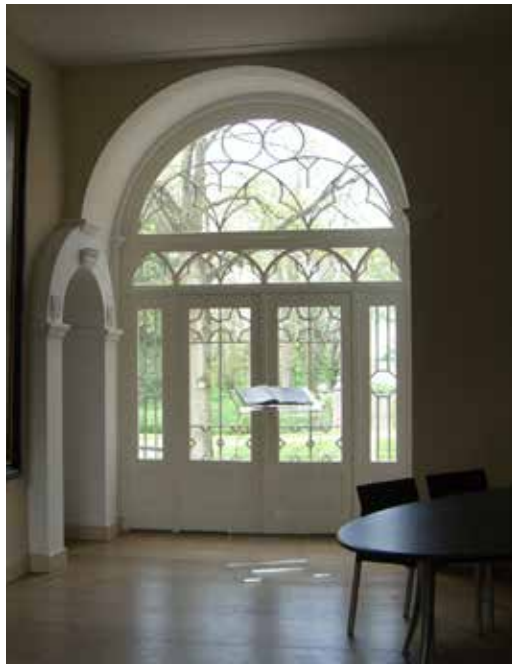
FIGUUR 4.18 Het nieuwe raam dat op basis van oud beeldmateriaal opnieuw werd gemaakt, 2008
