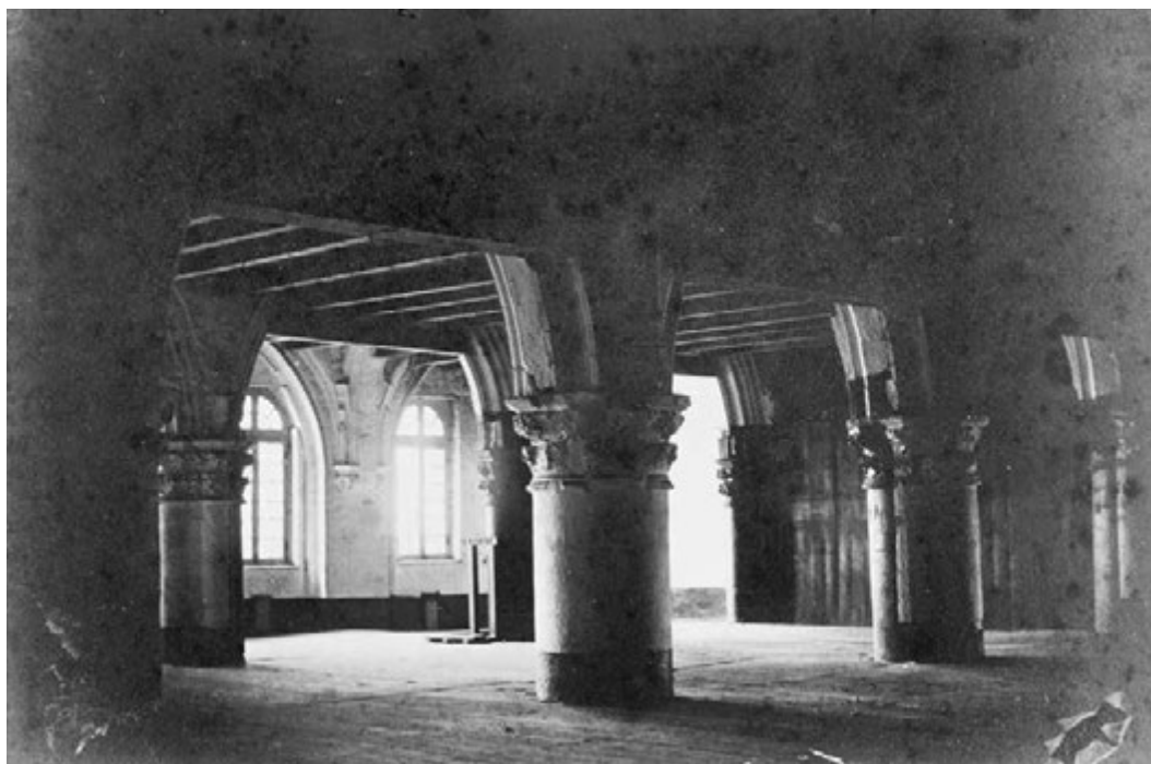
FIGUUR 3.3 Voordat de Grote Kerk een rijksmonument werd en de door de Fransen aangebrachte vloeren werden verwijderd, werd de kerk gedocumenteerd. De toen gemaakte tekeningen en foto's tonen de toestand van voor 1892. (Vloer in het zijschip aan de zuidzijde van het middenschip)
