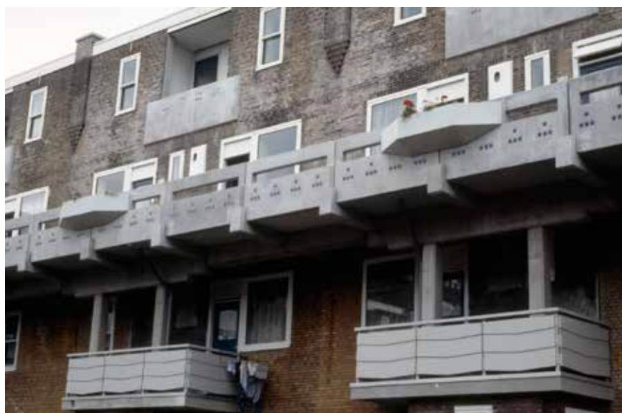
FIGUUR 5.7 Bij de renovatie van het complex werd de betonnen galerij vervangen, werden de plantenbakken uitgevoerd in wit kunststof en werd de indeling van de woningen gewijzigd. De foto uit 1985 toont het eindresultaat van de gevelreiniging.
