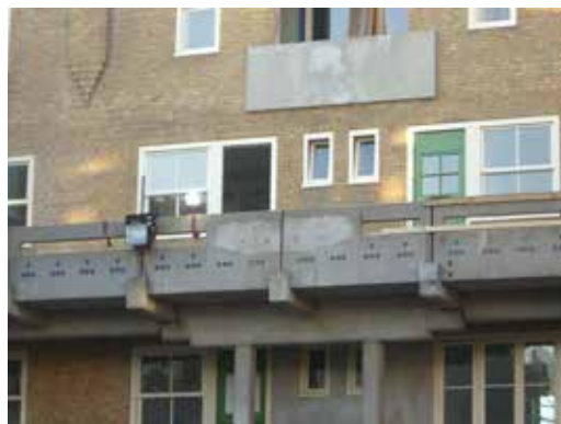
FIGUUR 5.18 Bij de restauratie werden de kunststoffen plantenbakken verwijderd en vervangen door betonnen exemplaren. Ook werd de oorspronkelijke raamverdeling en kleurstelling van het schilderwerk teruggebracht, 2012
