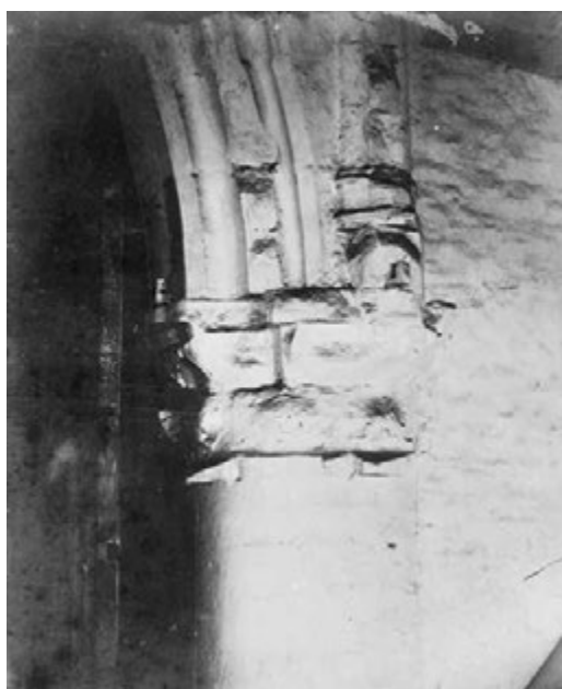
FIGUUR 3.4 Voordat de Grote Kerk een rijksmonument werd en de door de Fransen aangebrachte vloeren werden verwijderd, werd de kerk gedocumenteerd. De toen gemaakte tekeningen en foto's tonen de toestand van voor 1892. (Een van de beschadigde zuilen van het middenschip)
