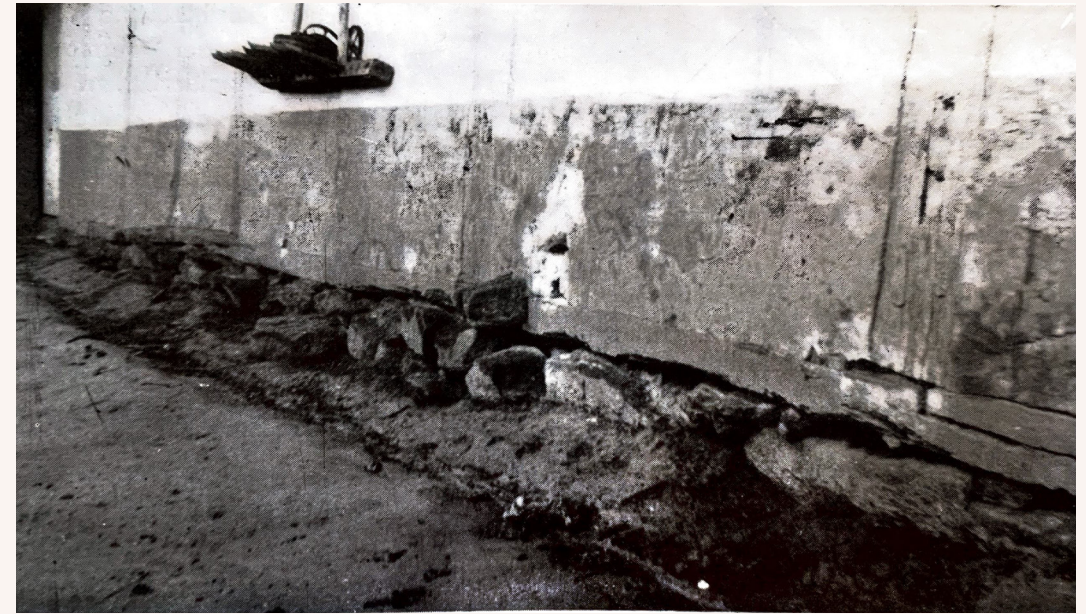
Figure 2.11: 'Stoel' foundation for the prevention of moist going up (Trefois, Ontwikkelingsgeschiedenis van de landelijke architectuur , 1950)
