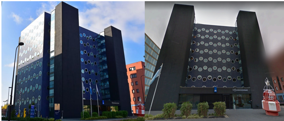
Fig 16. Pictures of the Rijkswaterstaat building (Cobouw, 2019)
