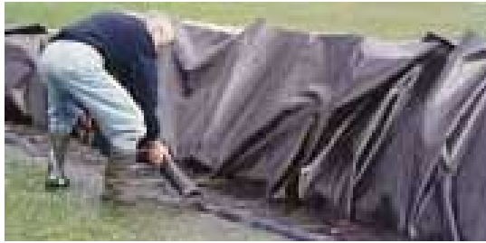
Figuur 6.4 Op het geomembraan worden verzwaringen aangebracht, zodat de uiteinden van het membraan een “goede” aansluiting hebben met de ondergrond en zodat deze niet omslaan.
