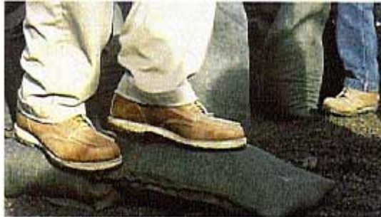
Figuur 3.7 Voor een goede aansluiting dienen alle zakken goed aangestampd te worden.
