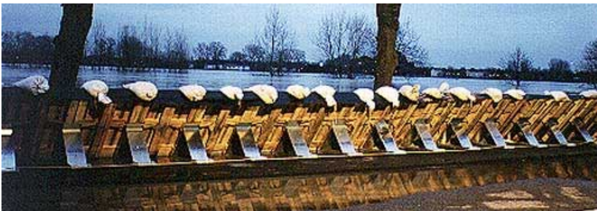
Figuur 5.13 De Aquabarrier als waterkering; het water komt door de bodem omhoog [29].
