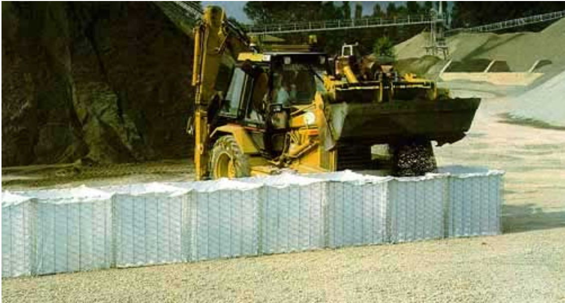
Figuur 5.7 Door het inzetten van groot materieel kan de installatietijd van het systeem worden verkort.
