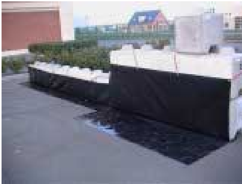
Figuur 6.9 Betonnen elementen van verschillende lengten worden door middel van zwaar materieel als lego-stenen op elkaar geplaatst.
