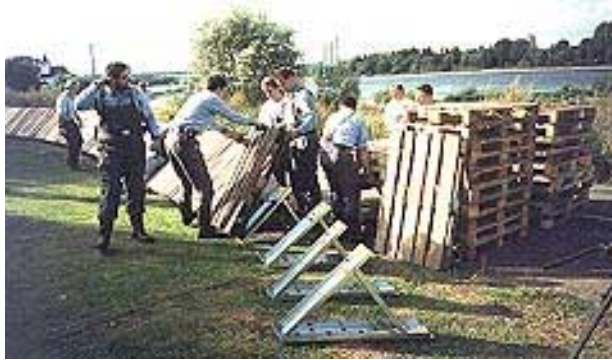
Figuur 6.18 De Aquabarrier is veruit het snelste systeem in het opzetten in vergelijking met de andere tijdelijke waterkeringen. Er wordt dan wel gebruik gemaakt van een heftruck, maar ook zonder heftruck kan het systeem worden geïnstalleerd.
