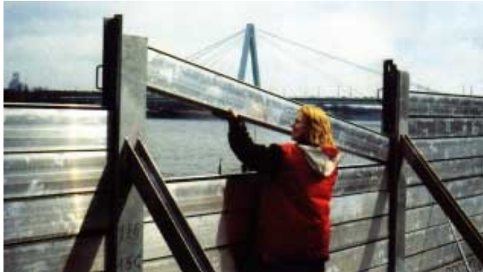
Figuur 5.15 De aluminium profielen zorgen voor een snelle en gemakkelijke opbouw van het systeem[30].
