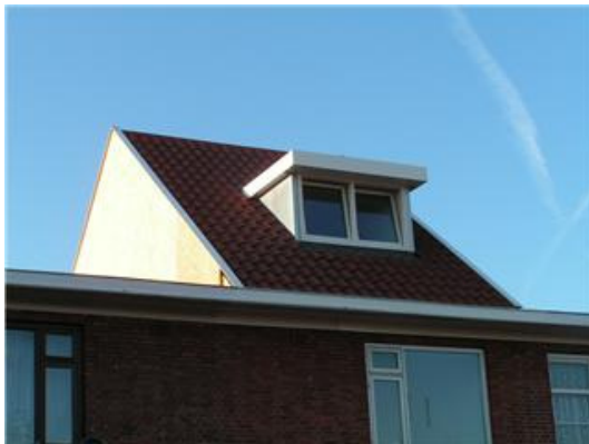
30. Eerste dakopbouw in de straat.
