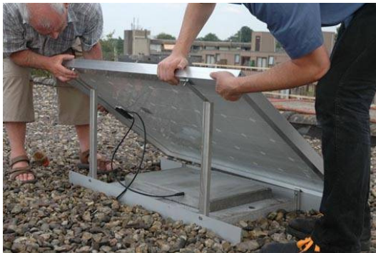
23. Plaatsen zonnepaneel op platdak.
