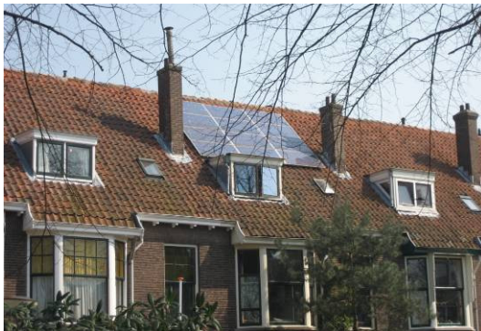
8. Zonnepanelen op bestaande bouw.
