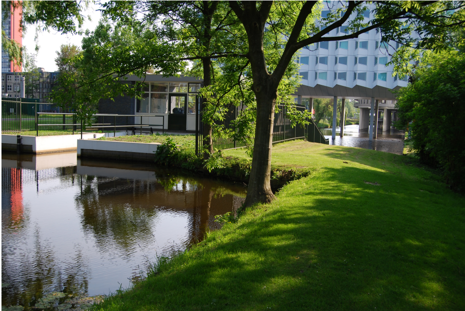
Figuur 8.1: Gemaal aan de Balthasar van der Polweg in Delft. De foto is genomen vanaf een oever langs het hoge pand. Op de achtergrond is het lage pand te zien.
