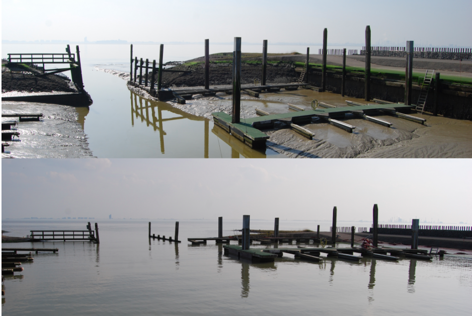
Figuur 5.3: Voorbeeld van een getijhaven: twee opnames van de haven van Ellewoutsdijk, gelegen aan de noordelijke oever van de Westerschelde. De foto's zijn ongeveer 8 uur na elkaar gemaakt in zuidelijke richting, de bovenste 's morgens en de onderste 's avonds.
