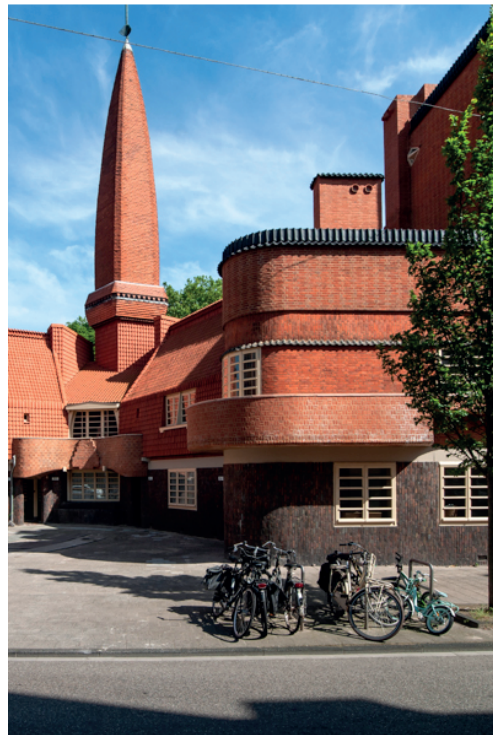
Renovation Het Schip, Archivolt architecten
