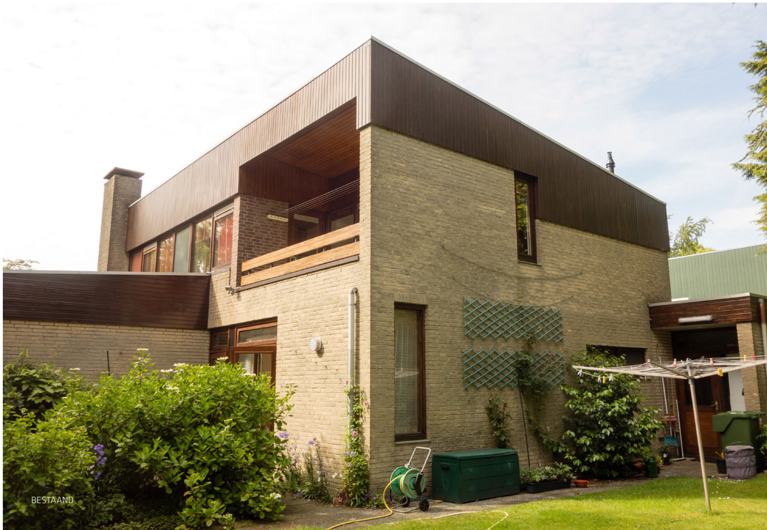
Villa Voorschoten, before renovation (Jade Architecten, 2017)
