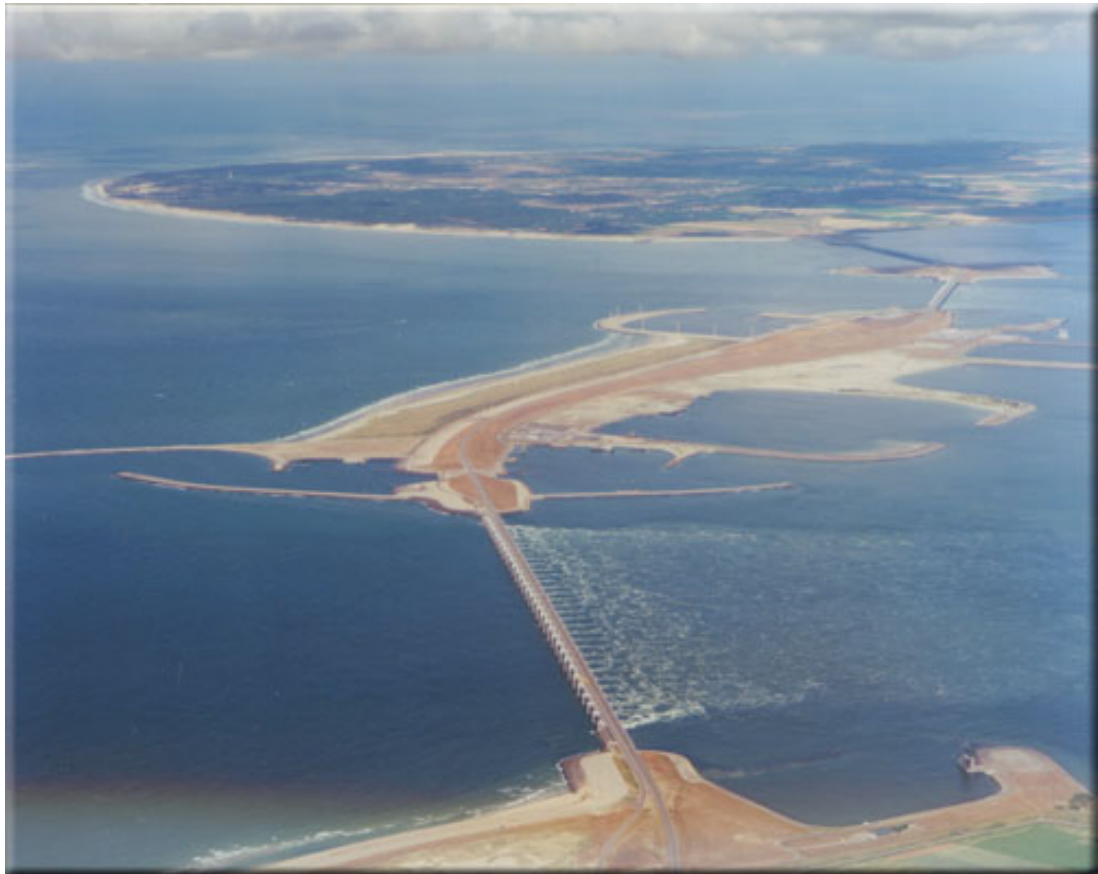
Figuur 2-2 Stormvloedkering Oosterschelde, zicht naar het noorden, vloedsituatie
