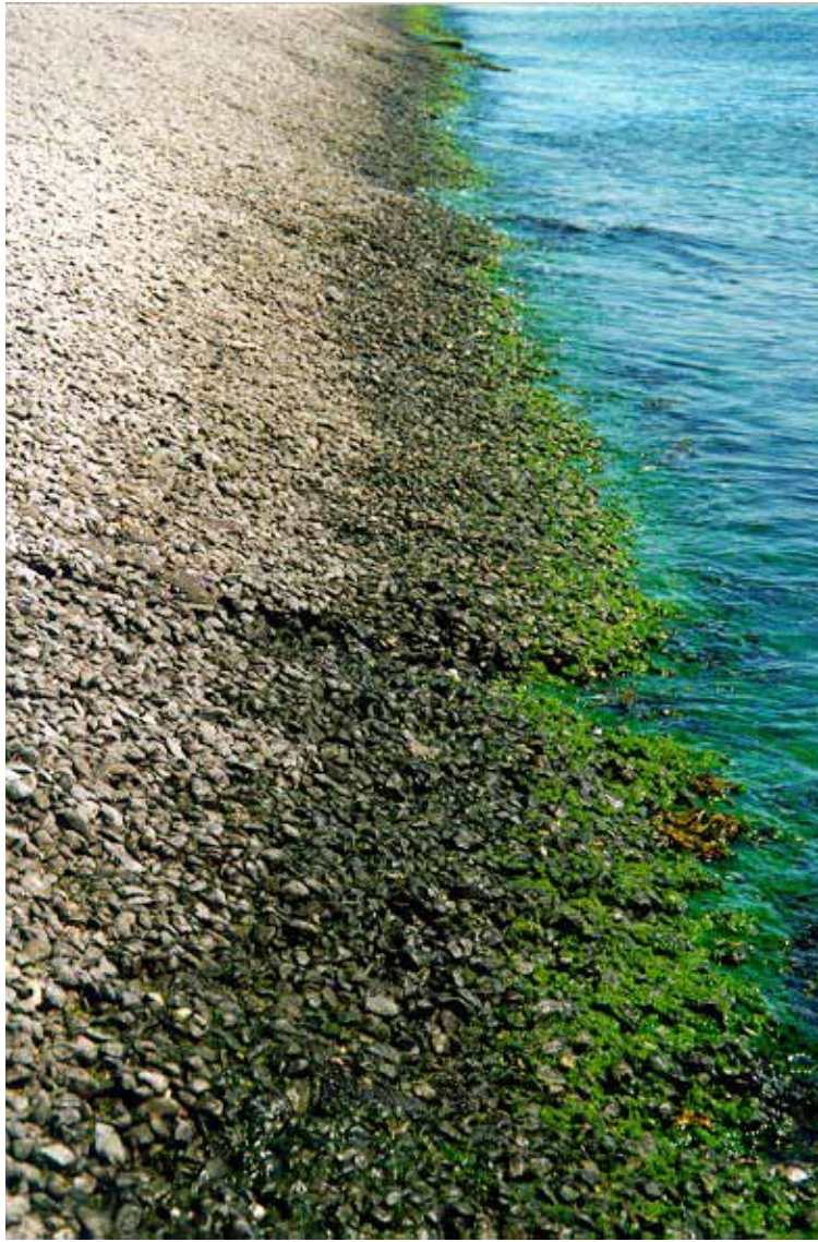
Figuur A2.4 Aangetast oppervlak ter plaatse van de tijzone (Noordland, 1996)
