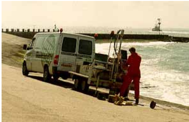
Figuur B3.1 Het nemen van boorkernen uit een bekleding
