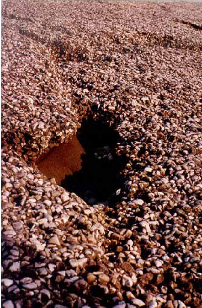
Figuur A2.8 Gat in de bekleding, onderliggende filter (zandasfalt) zichtbaar (Bouwput Schaar, 1978)
