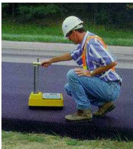
Figuur A2.3 Troxler op asfaltverharding
