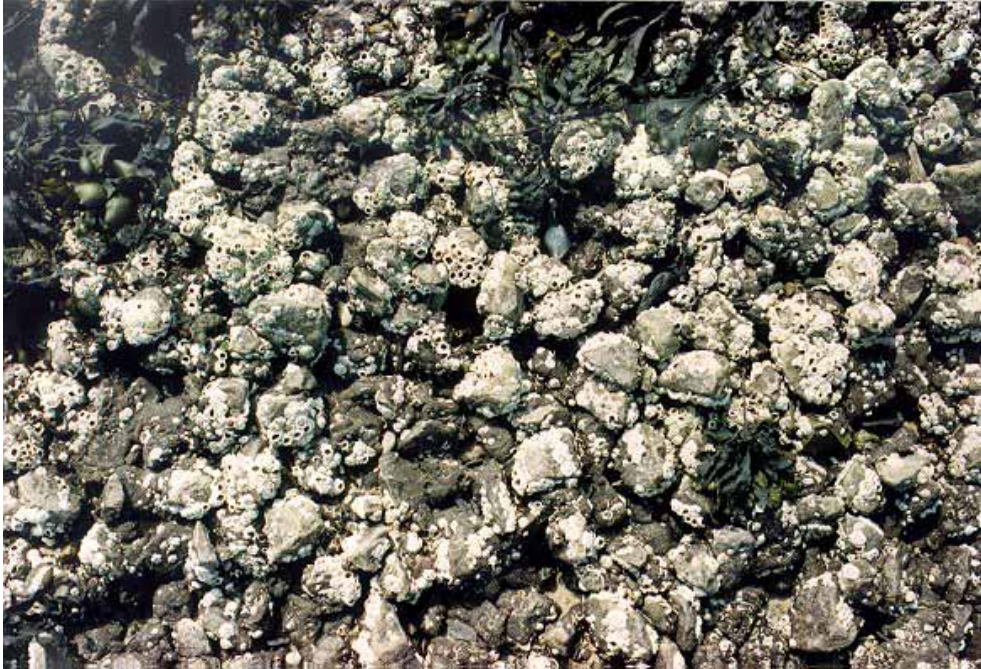
Figuur A2.6 Aantasting door zeepokken, waardoor de bovenste steentjes vrijwel los liggen (vluchthaven Neeltje Jans, 1989)
