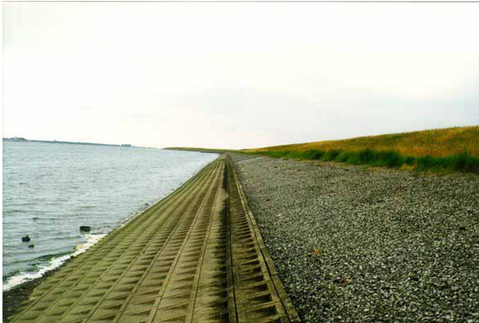
Figuur A2.2 Overzicht van een open steenasfaltbekleding (st. Philipsland, Tholen, 1996)
