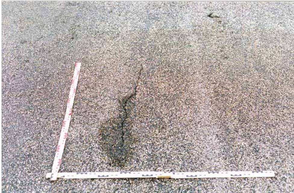
Figuur A1.8 Niet doorgaande scheur (Vlissingen, 1991)
