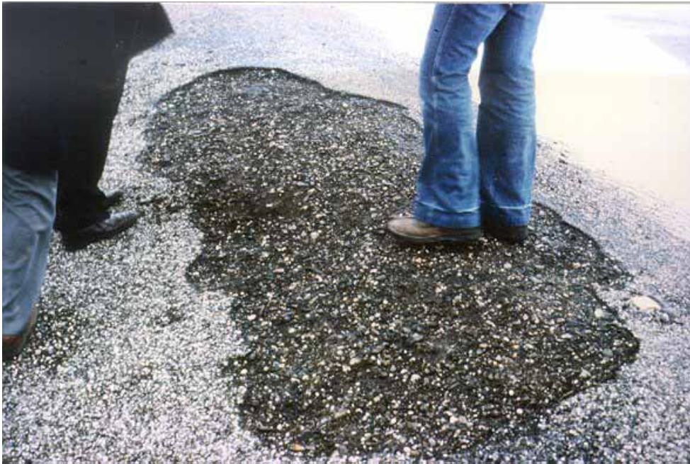
Figuur A1.21 Aangetast oppervlak, circa 1 steenlaag verdwenen (Banckspolder Schiermonnikoog, 1981)
