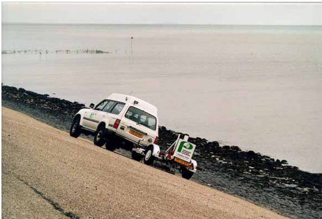
Figuur A2.9 Valgewicht-deflectiemeting op een dijktalud
