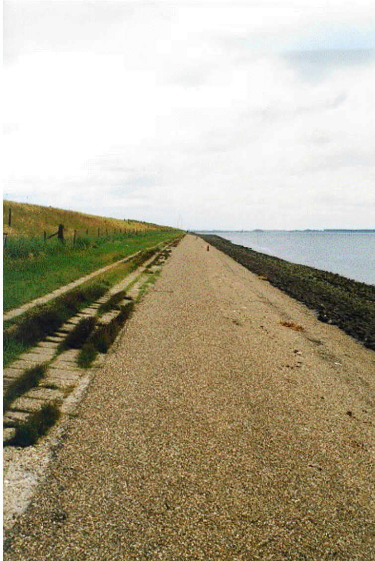
Figuur A1.2 Overzicht van een dijkbekleding van waterbouwasfaltbeton (Dijk nabij haven Middelharnis)
