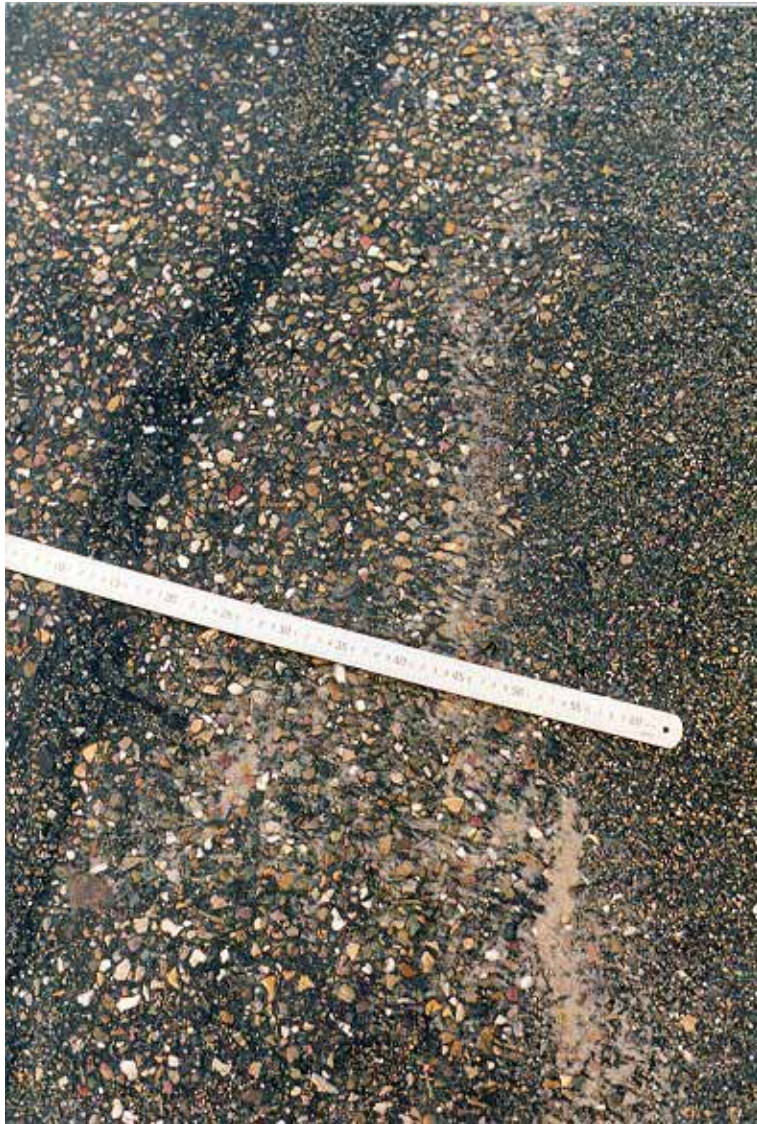
Figuur A1.21 Verdwijnen van de oppervlaktebehandeling. (Vlissingen, 1993)
