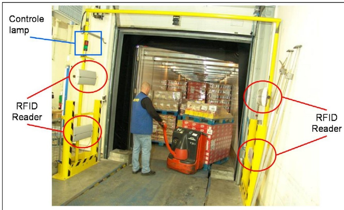
figuur 39: RFID reader constructie bij een dock deur
