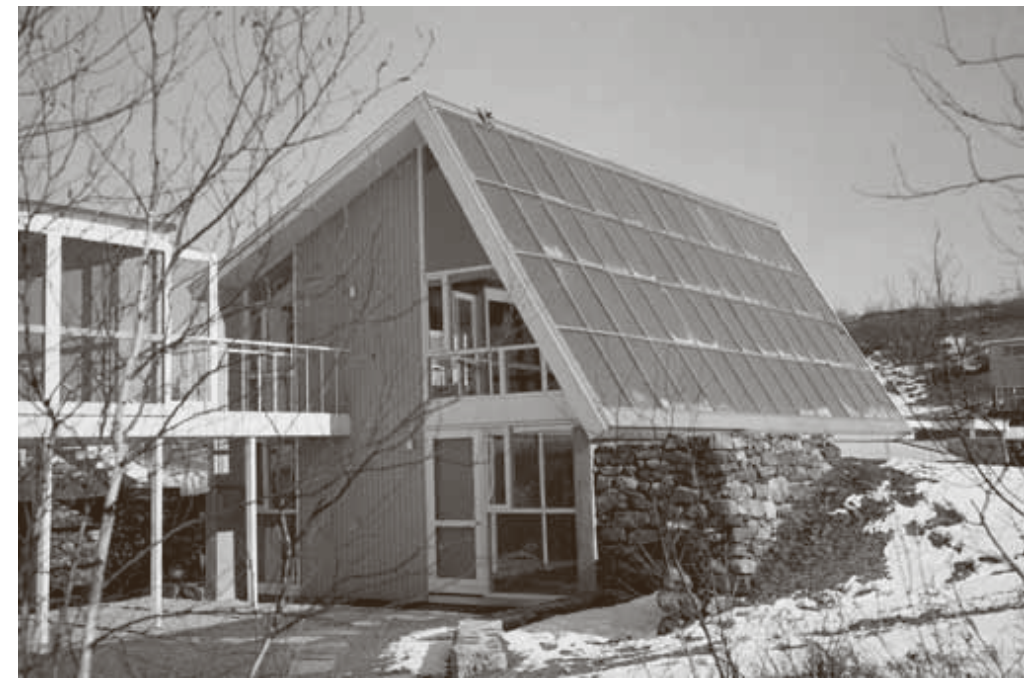
1 MIT Solar House 4, completed in 1959, displaying active solar technology on the roof. [Courtesy MIT Museum]
