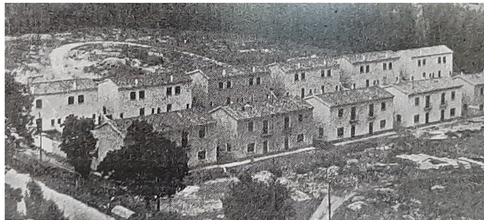
EL NUEVO GRUPO DE VIVIENDAS DEL "PATRONATO FRANCISCO I Constituyen un bello conjunto resultado de un alarde de buen gusto y refinamiento
