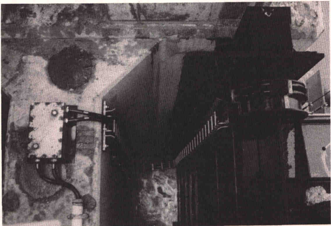
4. Schuif S13. Kabelketting in schuifspinning
