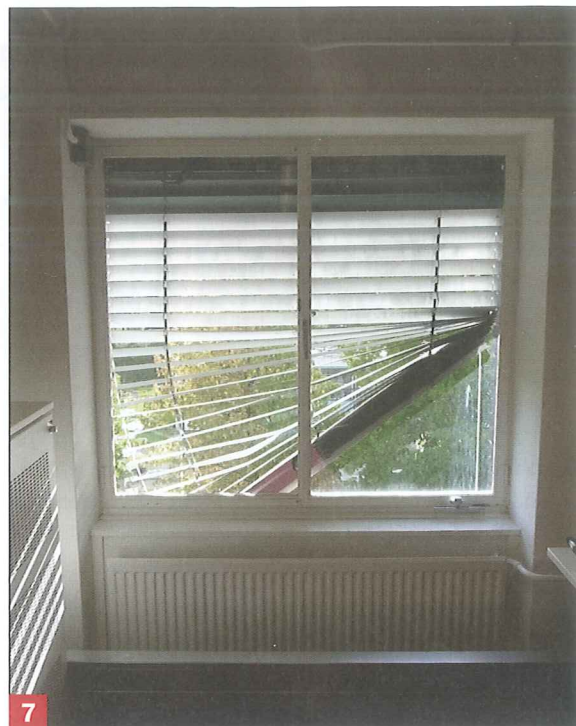
Traditionele mechanische daglichtsystemen zijn vaak erg onderhoudsgevoelig
