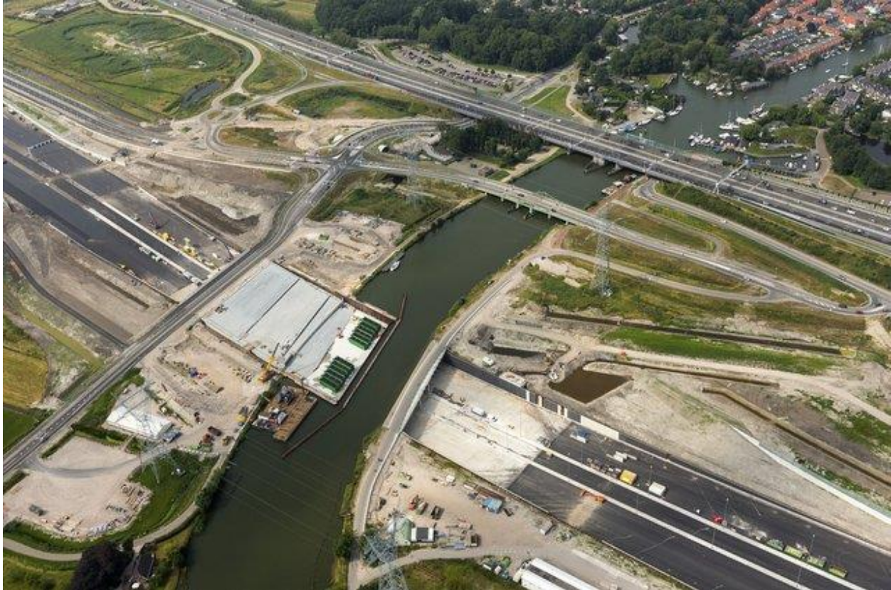
‘Luchtfoto van de bouw van het grootste aquaduct van Europa.’ door Aerovista Luchtfotografie (bron: Shutterstock )
