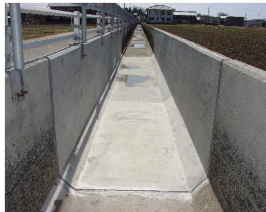
(d) After Repair
