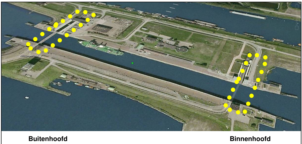
Foto 3: Overzicht sluis met 2 sluishoofden
