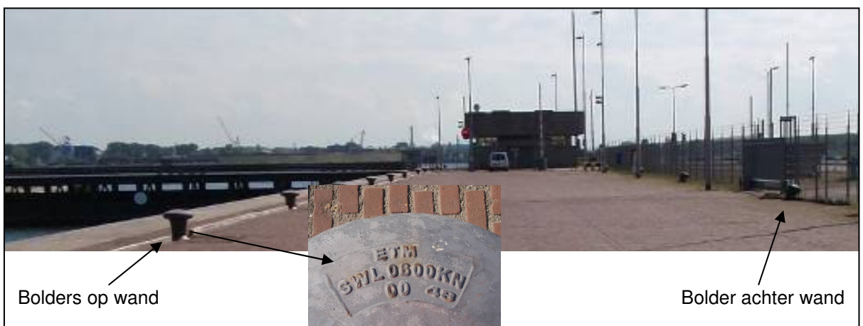
Foto 8: Bolders (uitgelicht detail bolder op wand, 600 kN)
