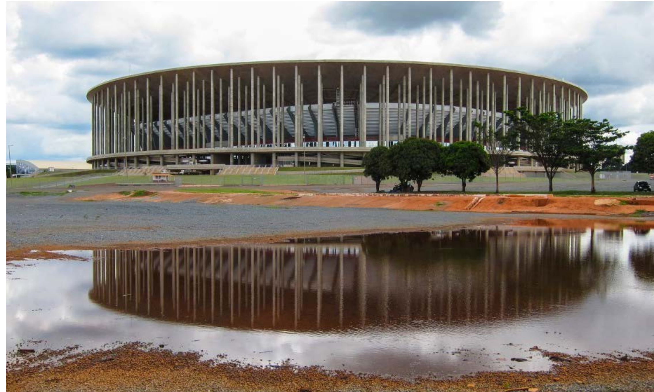
ESTÁDIO NACIONAL MANÉ GARRINCHA (1974 / 2013) BRASILIA, BRAZIL ARCHITECT: CASTRO MELLO ARQUITETOS, SCHLAICH BERGER- MANN UND PARTNER, GMP ARCHITEKTEN
