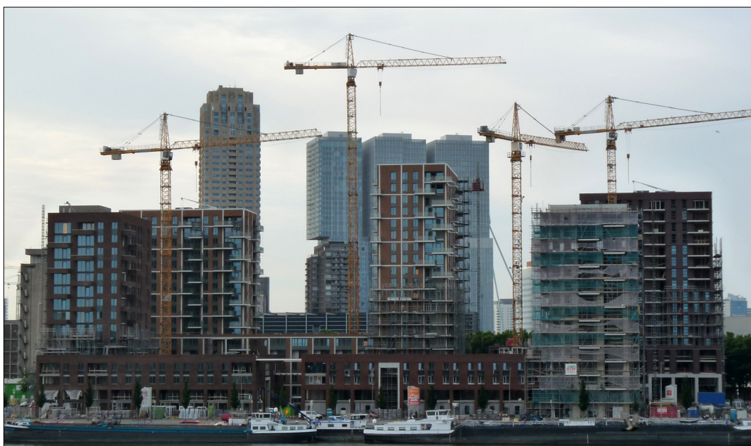
Fig. 2.110: Construction in Katendrecht, 18.07.2020
