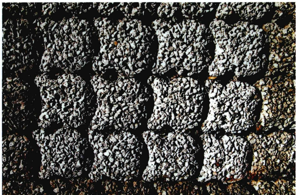
Foto 1.12 Betonzuilen met ecotop
