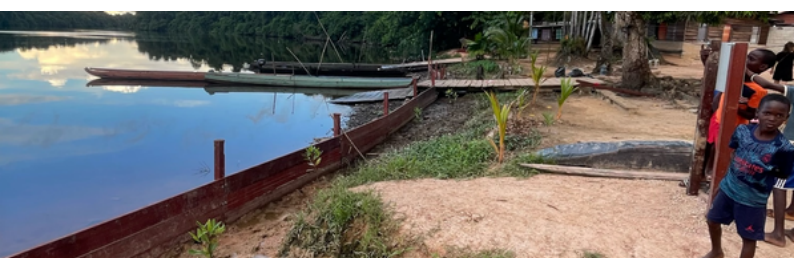
Figure 0.3: Prototype van de oeverprotectie (links) en de informatieborden die geplaatst zijn (rechts) (schrijvers' werk)
