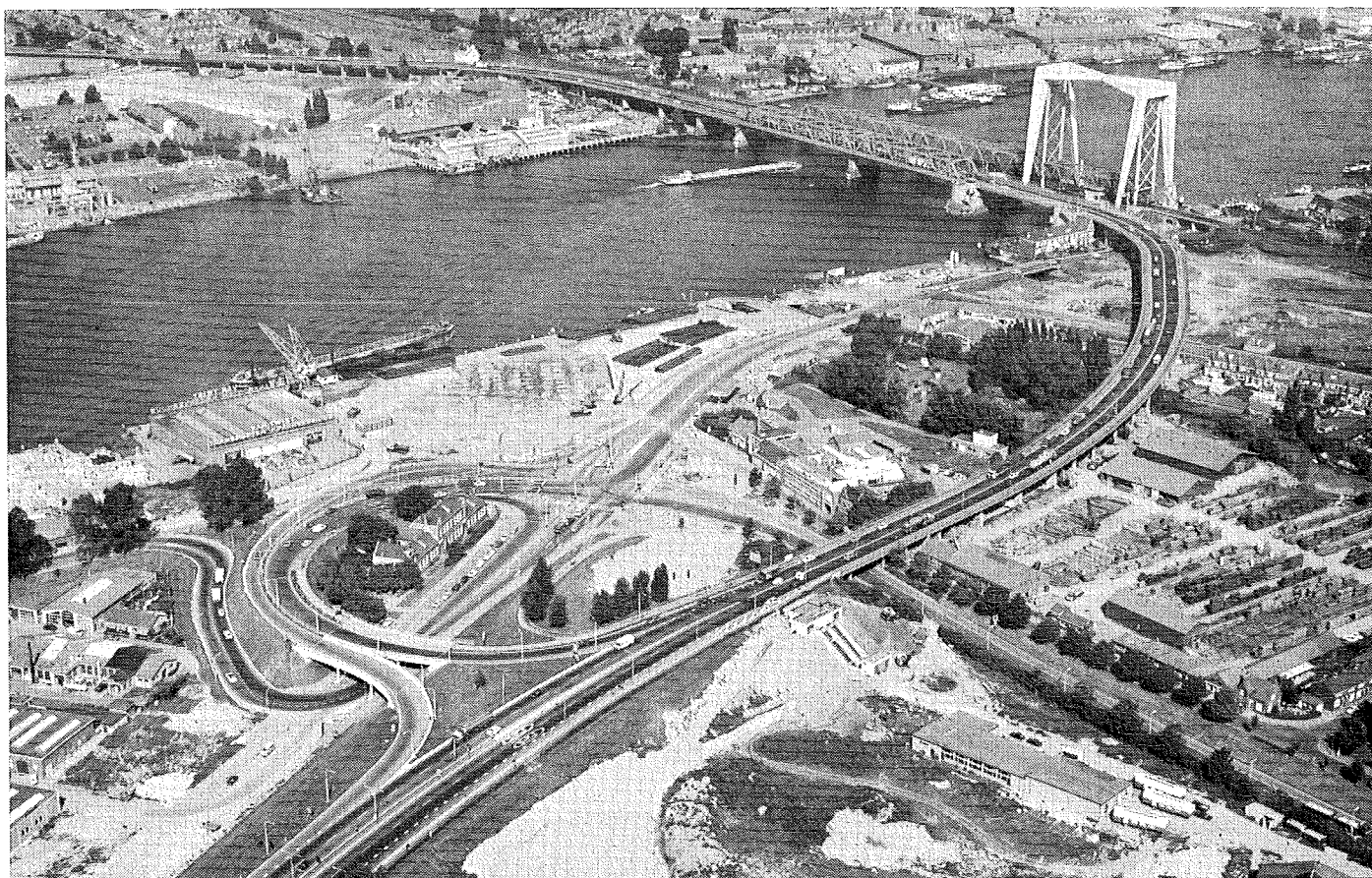
Overzicht situatie bij de brug over de Oude Maas tussen Dordrecht en Zwijndrecht Survey of the situation near the bridge over the Oude Maas foto: Aero-Camera, Rotterdam
