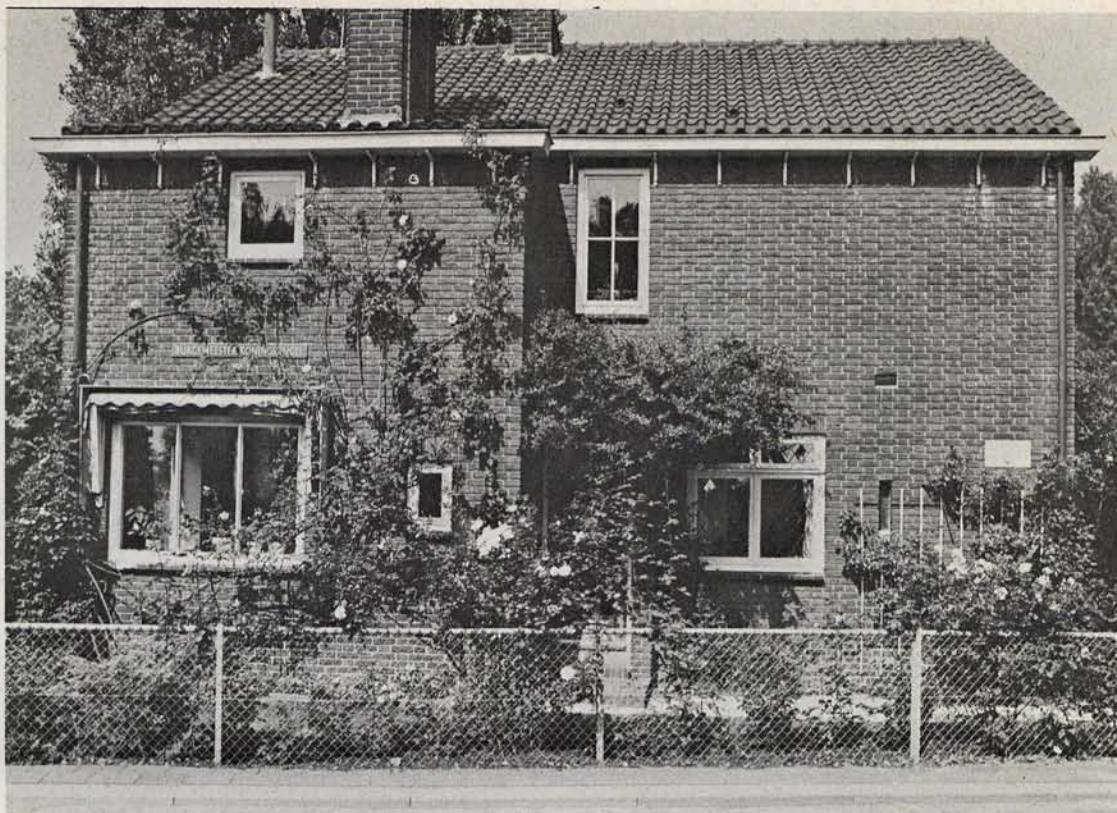
Fig. 43. De ramen in deze gevel zijn alle verschillend, de onder- en bovendorpels corresponderen slechts een enkele keer, waardoor weinig redundantie optreedt. Als gevolg daarvan 'hangen' de ramen 'los' in het gevelvlak. Zie fig. 32.
