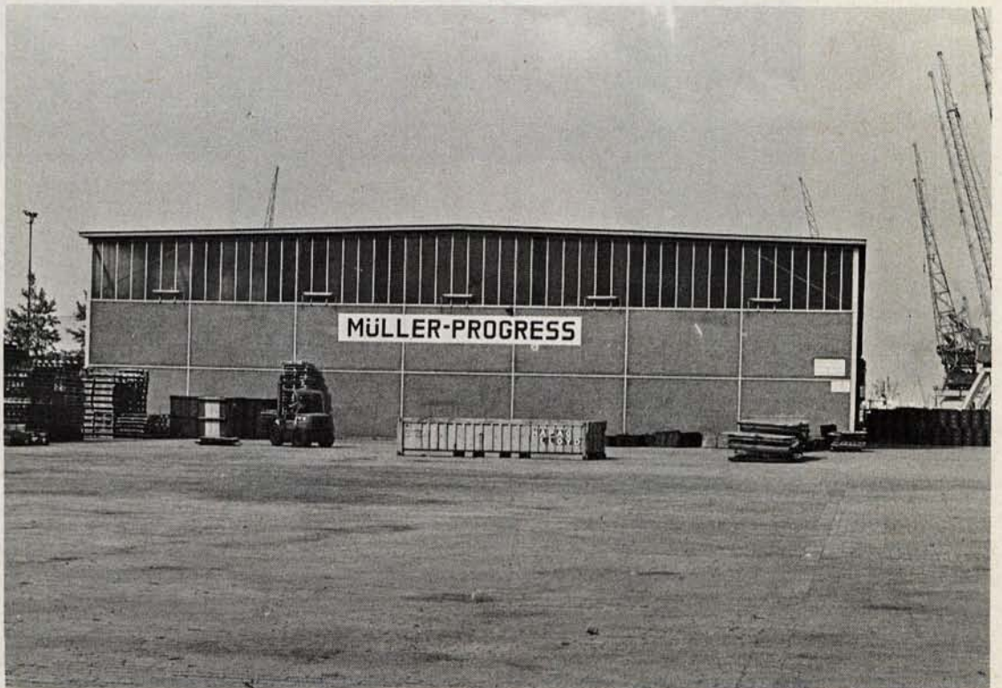
Fig. 47. T.g.v. flauwe dakhellingen gaat de vorm van de eindgevel veel lijken op een rechthoek; door onze richtinggevoeligheid en door de eenvoudiger vorm van de rechthoek ontstaat een onduidelijkheid.
