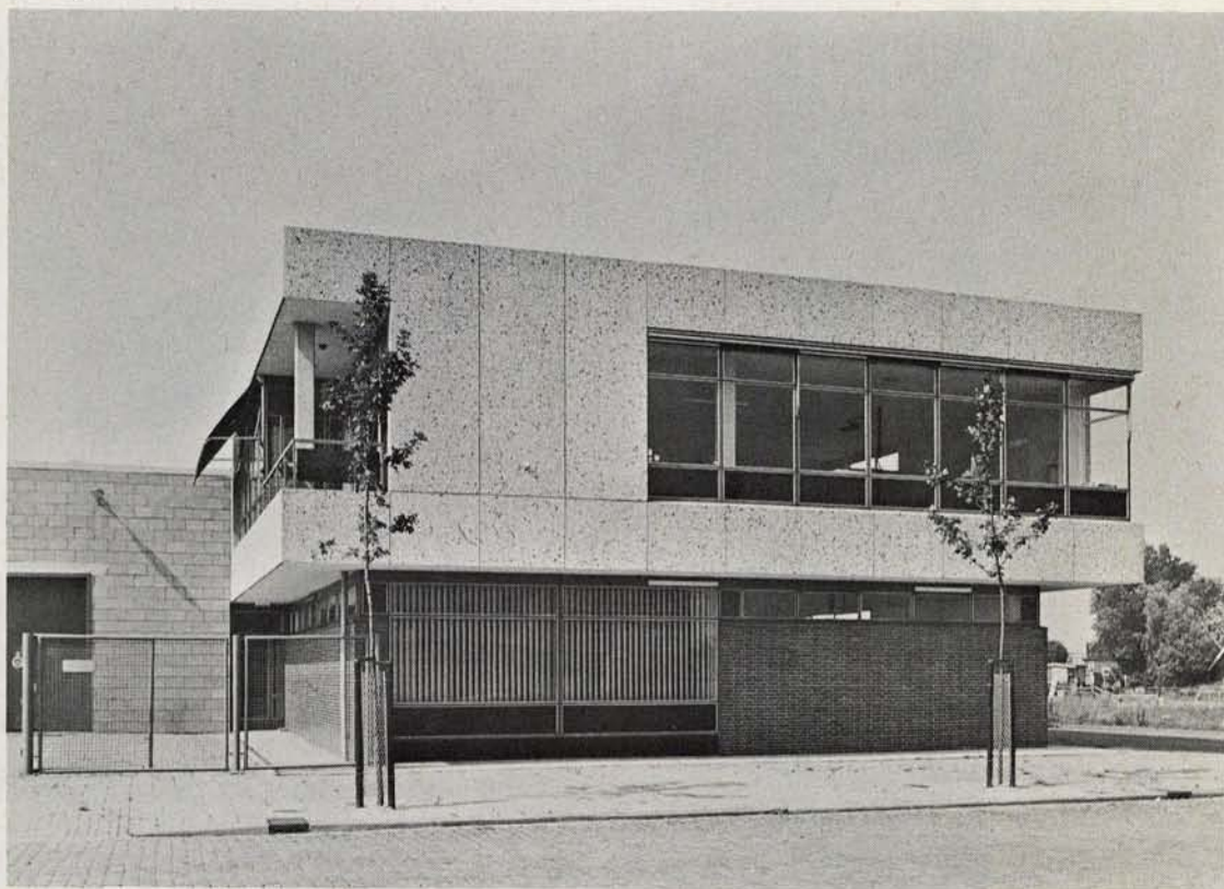
Fig. 44. Tegenhanger van fig. 43: gelijke maten en afstanden; ondervdeling in twee zones en veel doorlopende lijnen (continuïteit). Het bovendeeel is een omkeerbare figuur; het metselwerk kan als een liggende H worden gezien. (Het metselwerk van fig. 43 kan niet als een zelfstandige vorm worden gezien).
