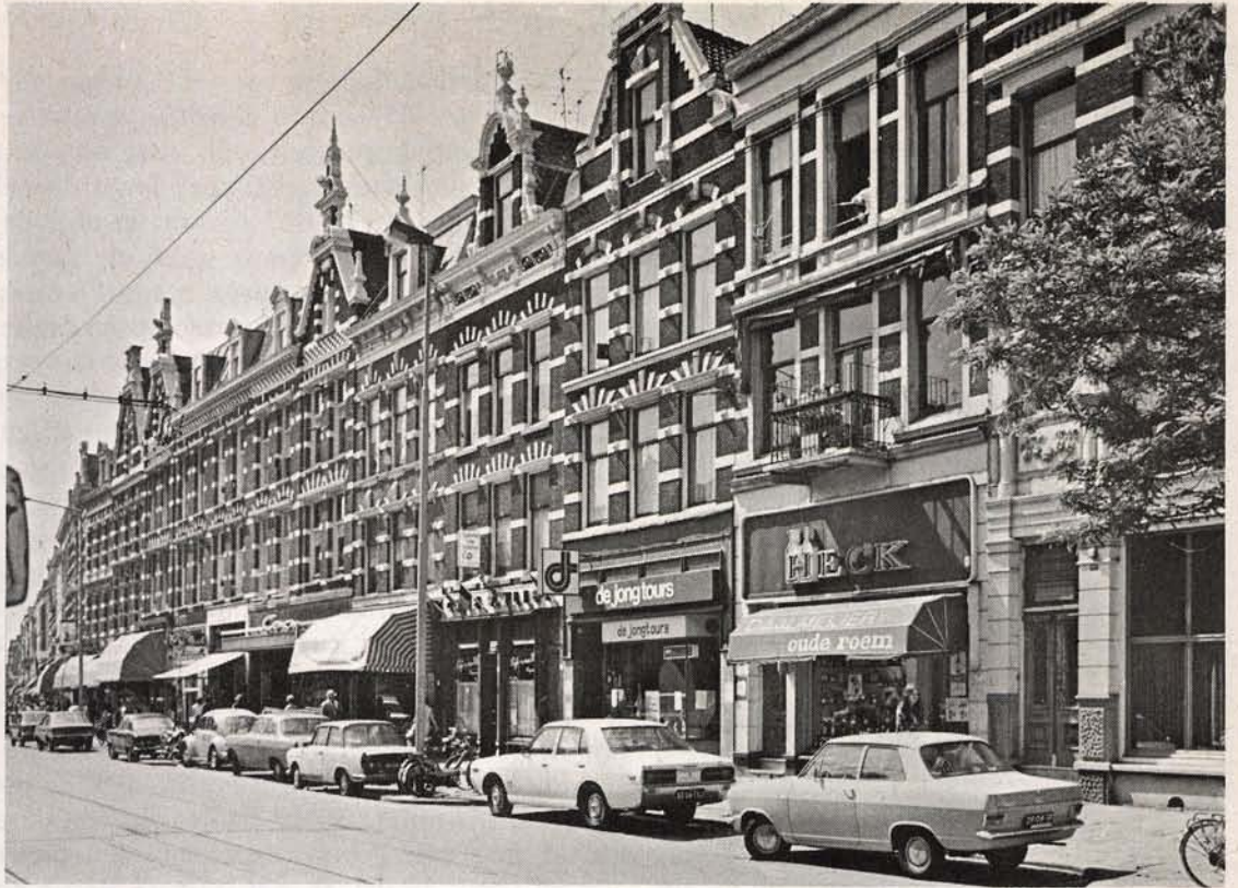
Fig. 89. Winkels en woonhuizen op de Kruiskade in Rotterdam. Een visueel 'rijke', d.i. complexe straatwand, door de verschillen tussen de winkelpuien en de woonhuizen.
