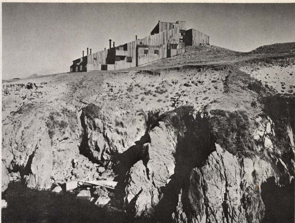
Fig. 98. Samenhang tussen een gebouw en landschap door de evenwijdigheid van de contouren. Woongebouw bij San Francisco.
