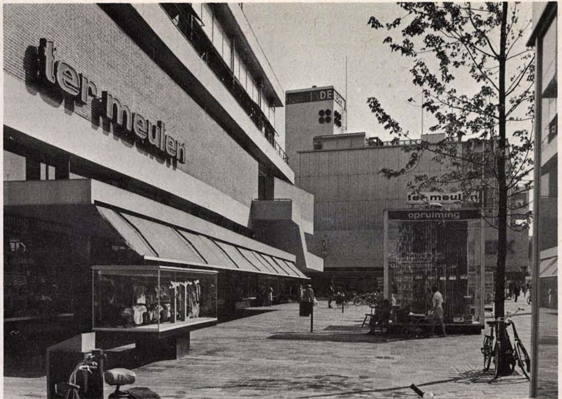
Fig. 102. De Binnenweg in Rotterdam. Achter het warenhuis van Ter Meulen loopt een straat onder een scheve hoek. Om een relatie tussen het warenhuis en deze straat te krijgen, heeft de architect een deel van de gevel naar deze straat toegedraaid; hij heeft echter dezelfde betonbanden en baksteenopbouw voor dit schiefsgelegde stuk gebruikt, waardoor het met de rest blijft samenhangen . . .
