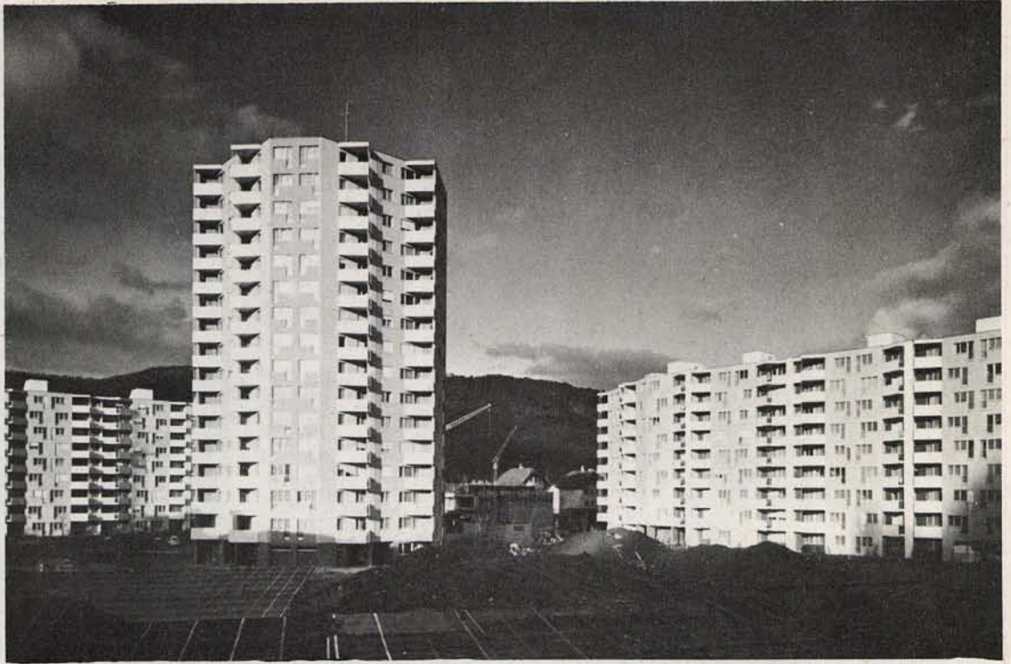
Fig. 100. Woongebouwen in Biel, Zwitserland. De torenflat contrasteert in hoogte en in zijn schiefhoekige plattegrond met de omringende bebouwing. De samenhang tussen deze verschillende gebouwen is bereikt door de herhaling van de schiefhoekige balcon en de raamvormen daartussen.
