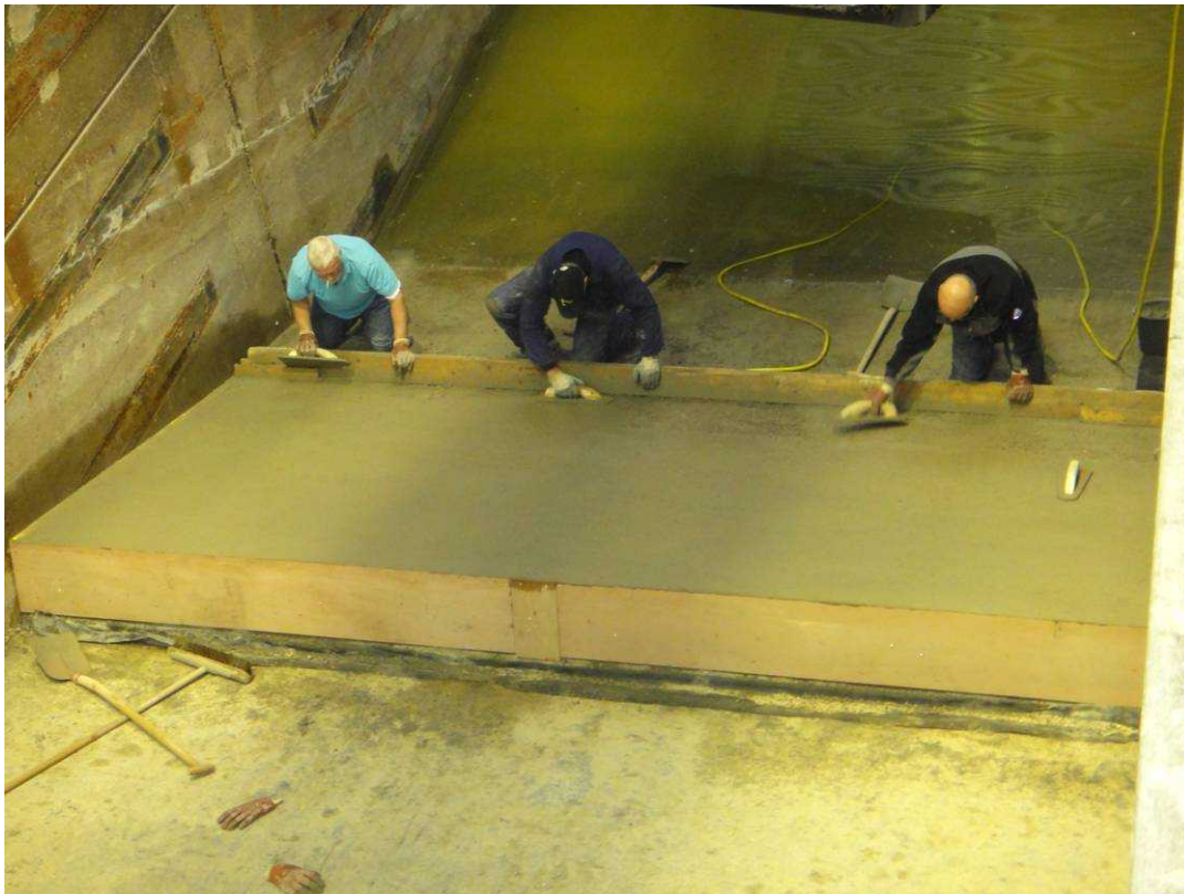
a) Constructie overgang betonnen sectie (1)
