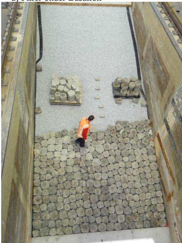
b) Aanbrengen Basalton
