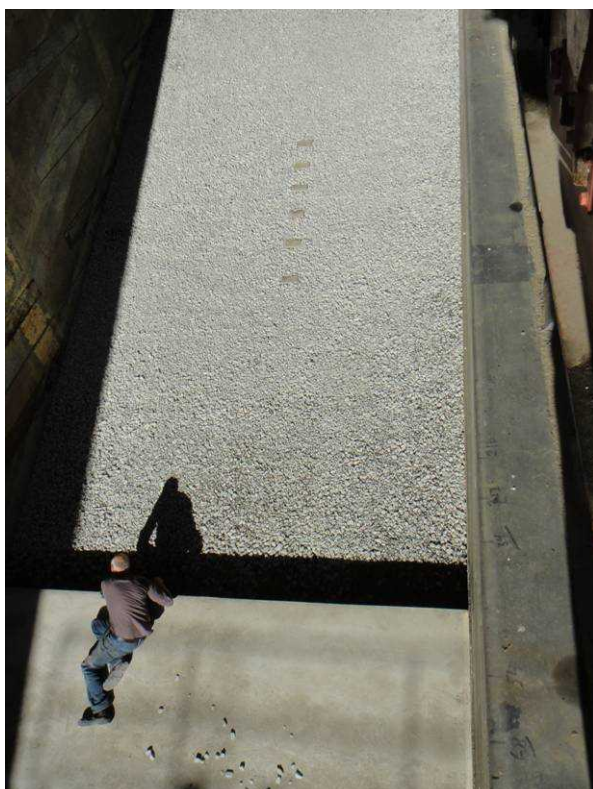
b) Aanbrengen onderste filterlaag (2)
