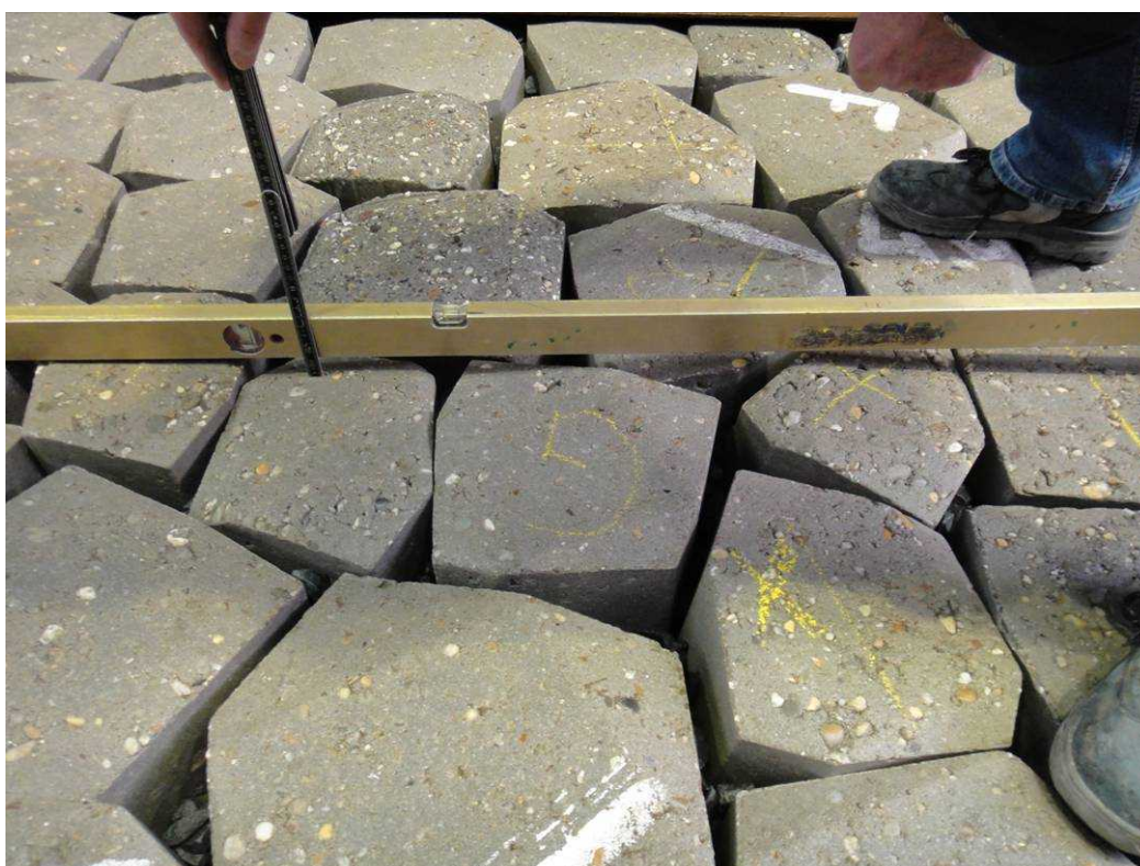
b) Schade na proef 8 (1)
