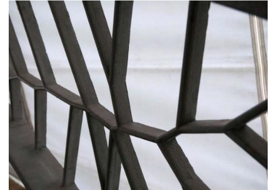
Parkbrug Voorstonden – Balustrade Fragment
