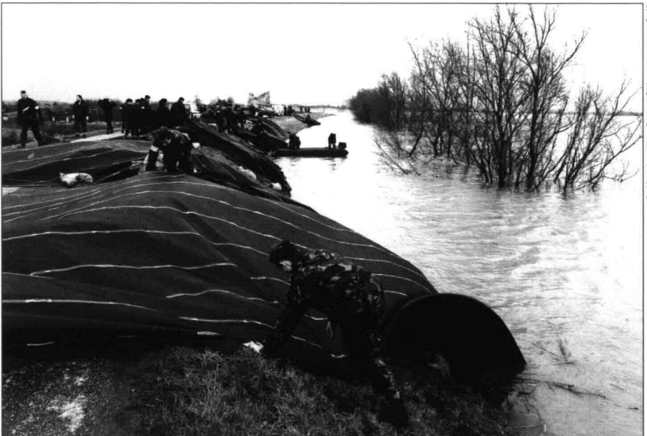
Noodreparaties aan de dijk bij Ochten tijdens extreem hoog water in de Waal in 1995.
