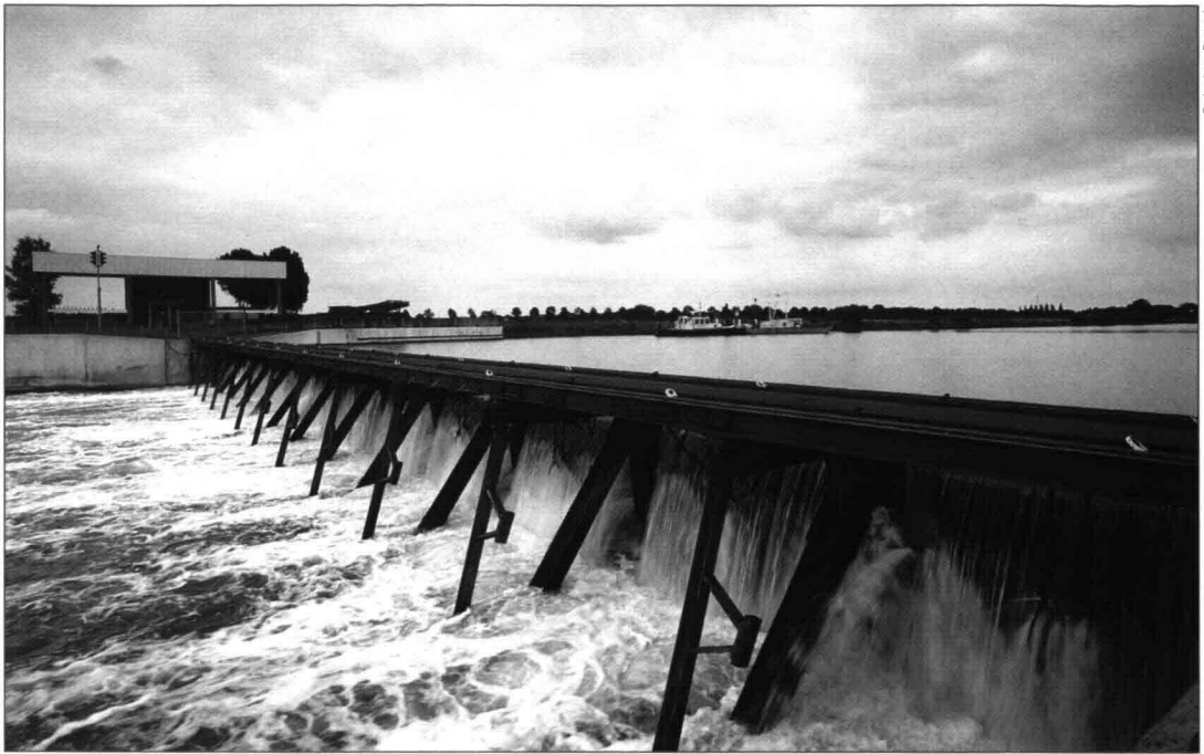
Poirée-schotten in het stuwcomplex Sambeek.
