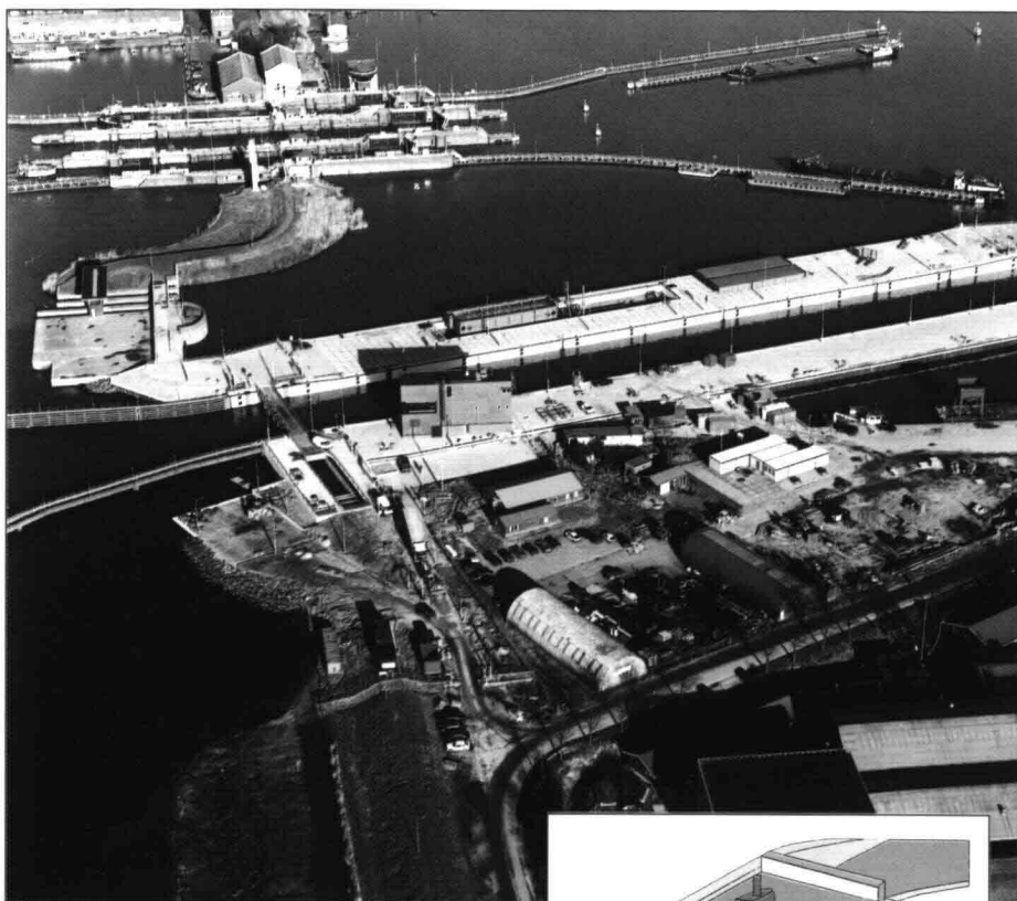
Deel van het Oranjesluizencomplex tussen het Binnen en Buiten IJ bij Amsterdam, waarin hydrostatistische lagers zijn aangebracht.
