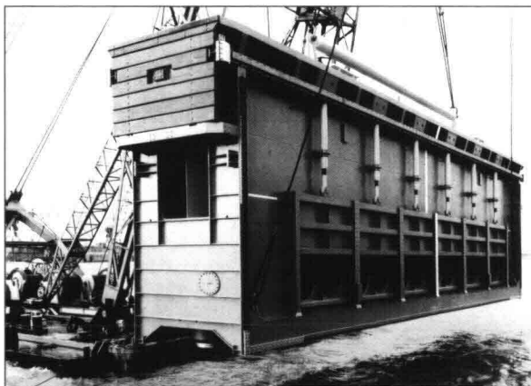
De sluisdeuren worden met een drijvende bok op hun plaats gehesen. Linksonderaan de deur is een van de hydrostatische lagers zichtbaar.
