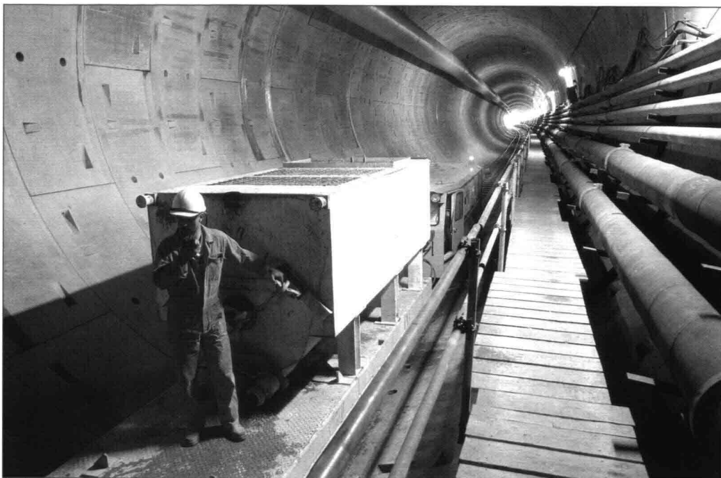
De fietstunnel van de aanbouw zijnde 2e Heinenoordtunnel is een mooi voorbeeld van een hightech-situatie.
