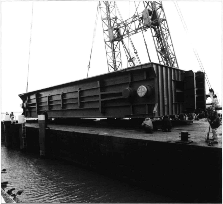
Een van de 180 ton zware sluisdeuren wordt nog aan een laatste inspectie onderworpen voor ze op haar plek wordt gehesen.
