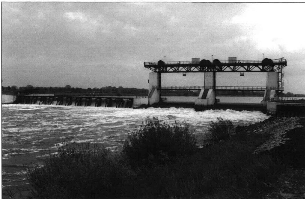
Het stuwcomplex Sambeek.
