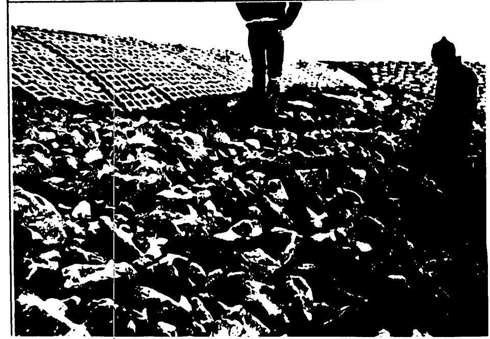
neg.nr. 32 omschr. Armorflex, beschadigde- en weggeslagen teenverdediging
