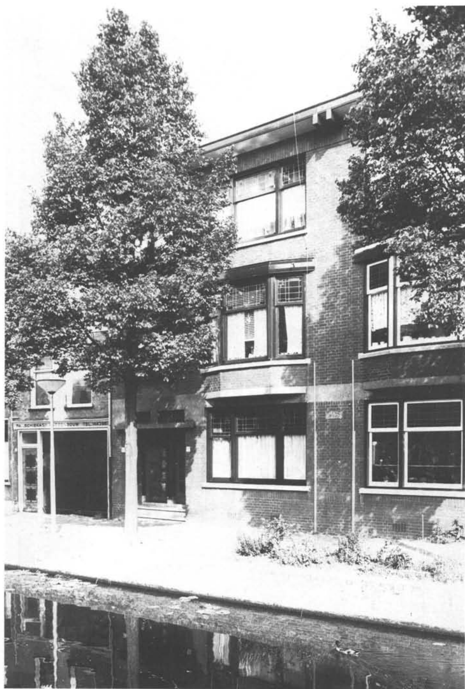
Bedrijf opgenomen in een woning
