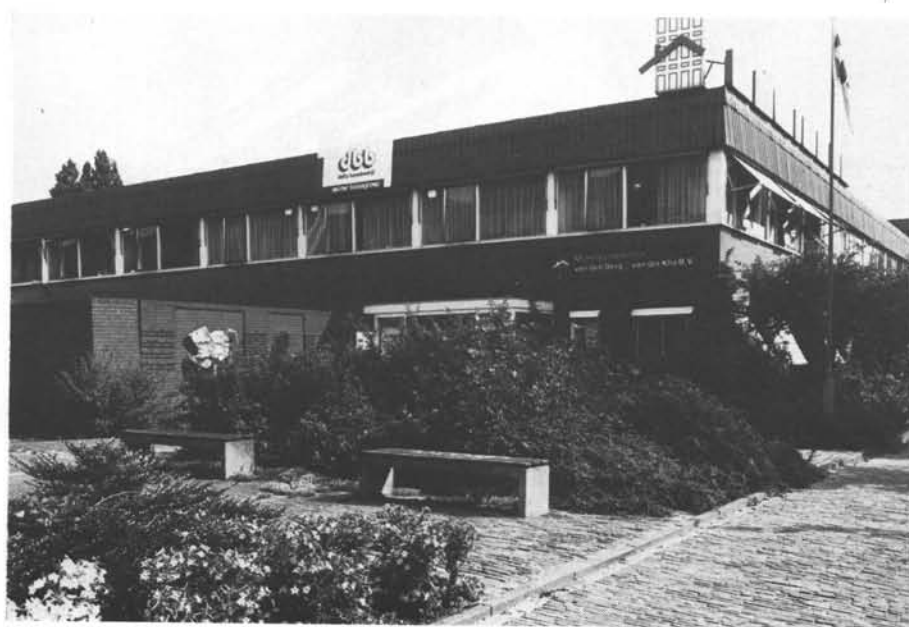
Een nieuw bedrijvencomplex
